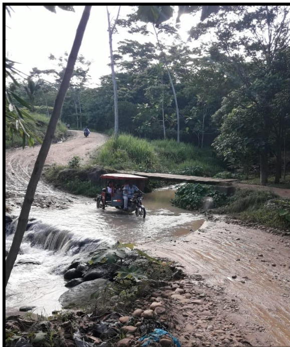
Foto N° 01: Se aprecia puente de madera provisional para peatones en pésimas condiciones, así mismo existe un badén por donde transitan los vehículos.
