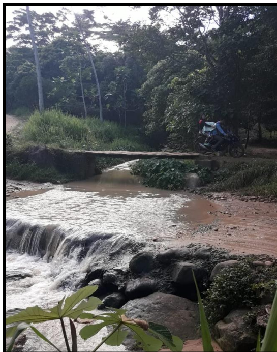
Foto N° 02: Se aprecia puente de madera provisional por donde transita vehículos menores y peatones, además la quebrada el Choclino, el cual falta realizar el encauzamiento de la corriente aguas arriba y aguas abajo.
