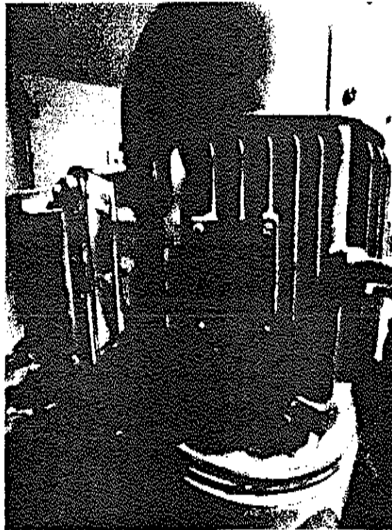
Imagen 13. Electrobombas de 10 HP, 380v, 3F, 60Hz.
