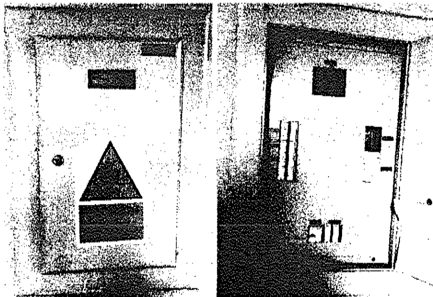
Imágenes 33. TABLERO ELÉCTRICO, TD-9, 380+N, 60Hz, 3F
