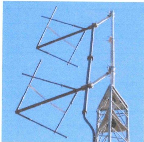
A) Conexión para arreglo de 2 antenas con divisor.
