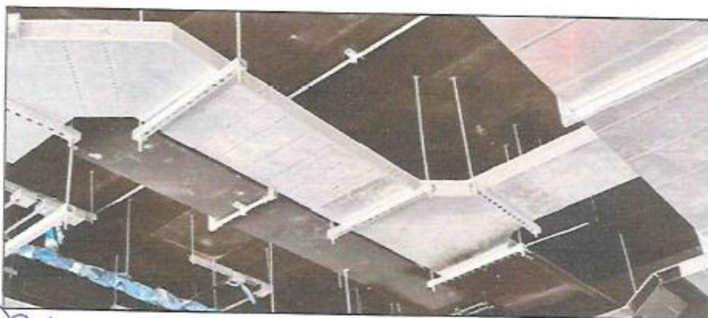
ESQUEMA 8 BANDEJAS METALICAS EN SALA DE MAQUINAS (SOTANO)
