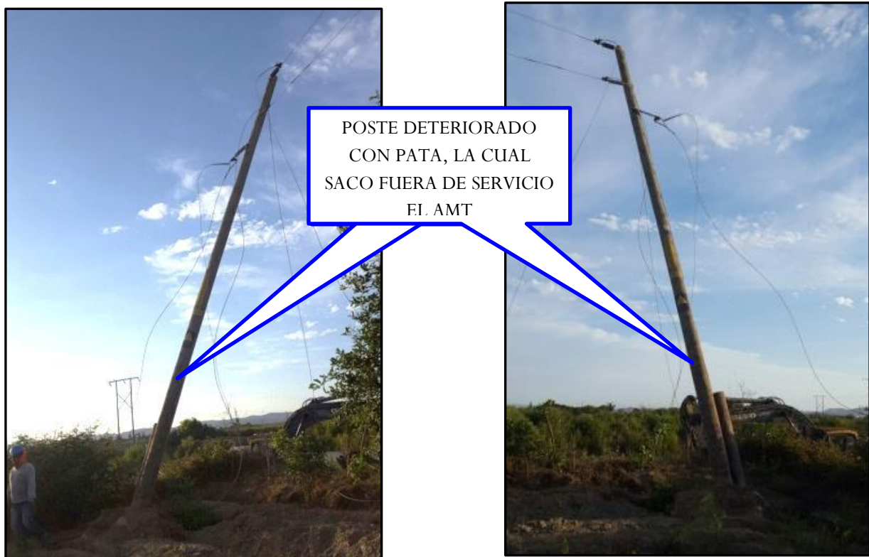
Figura N° 11: Postes de madera de media tensión deteriorados que están dentro de propiedades, incumpliendo DMS, estructuras y equipos de maniobras dentro de propiedad privada.
