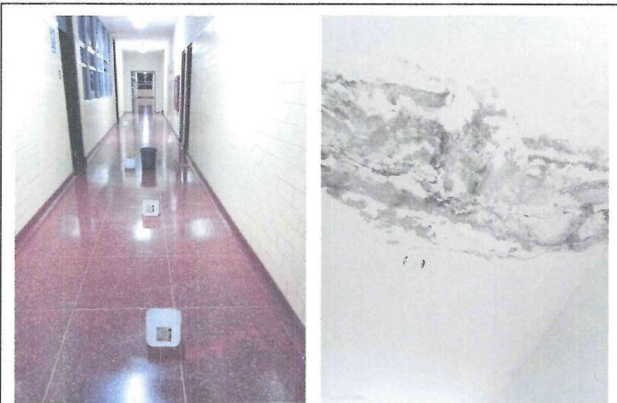
Fotos 07 y 08: Se observan filtraciones de agua de lluvia en los cielorasos de pasadizo lado Oeste de Centro Quirurgico
