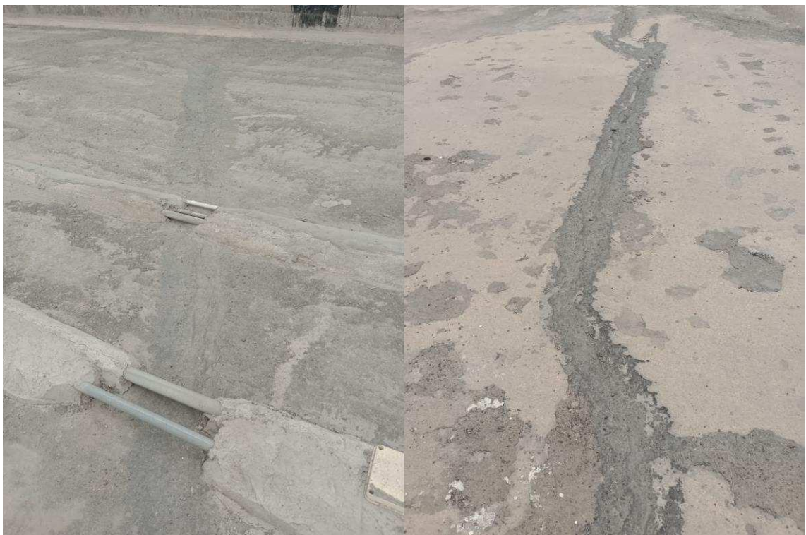
Ilustración 4 - Líneas reparadas con cemento y brea
