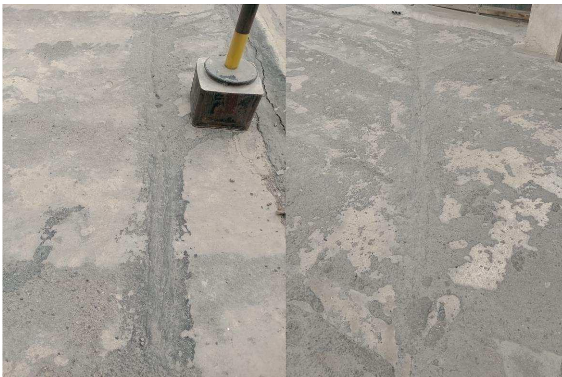
Ilustración 6 - Líneas de drenaje al patio 2 sin fisuras
