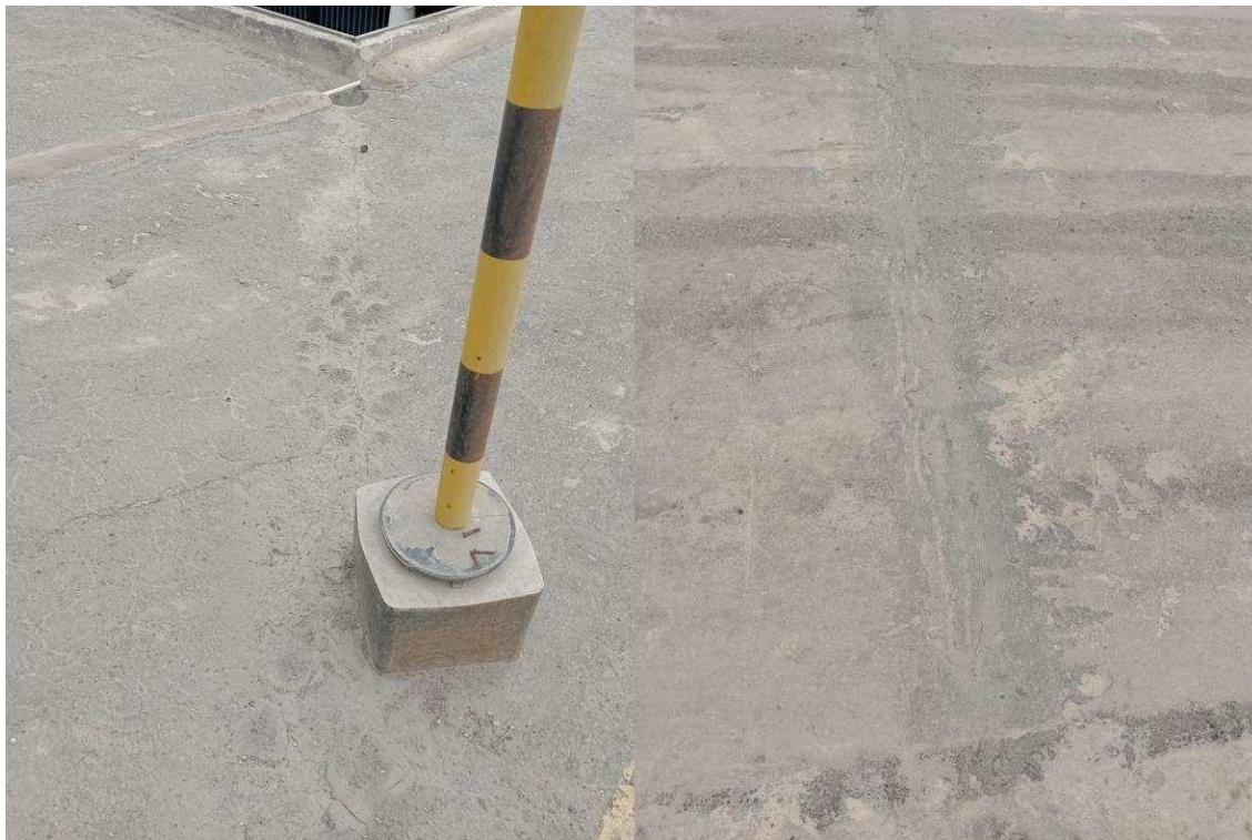
Ilustración 5 - Líneas de drenaje a patio 1 sin fisuras
