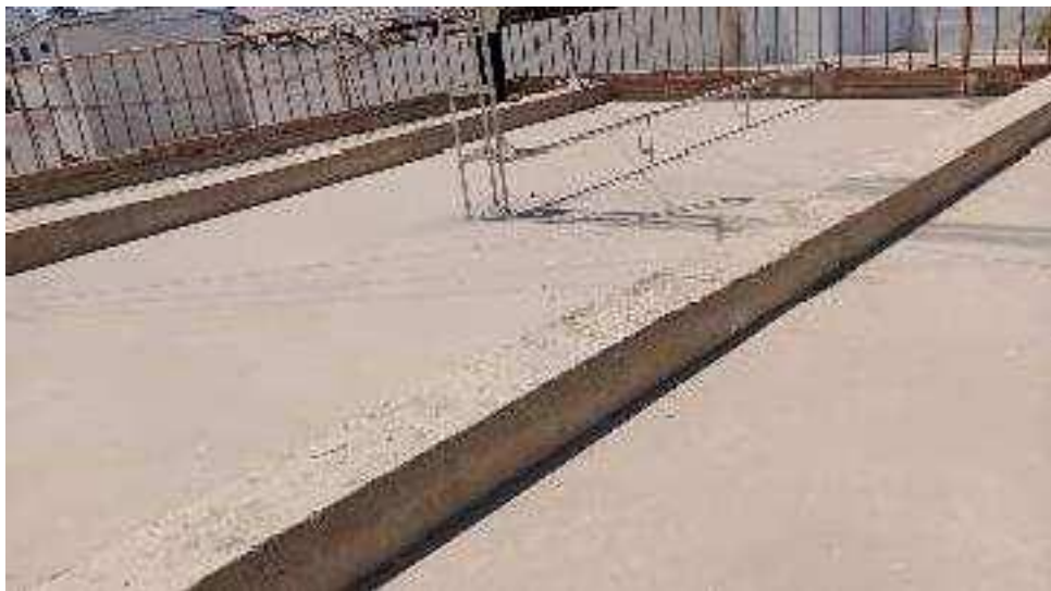
Fig. 09: Vista de las vigas peraltadas sobre el techo
