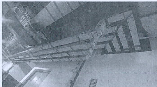
Ductos Barra y Tableros Eléctricos con Interruptor General.
