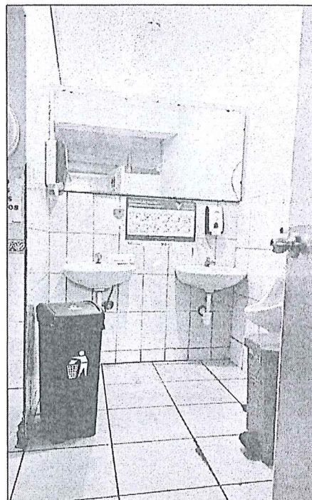
Imagen 4: ss.hh. de personal requiere de mantenimiento de piso y zócalo, asimismo cambio de urinarios
