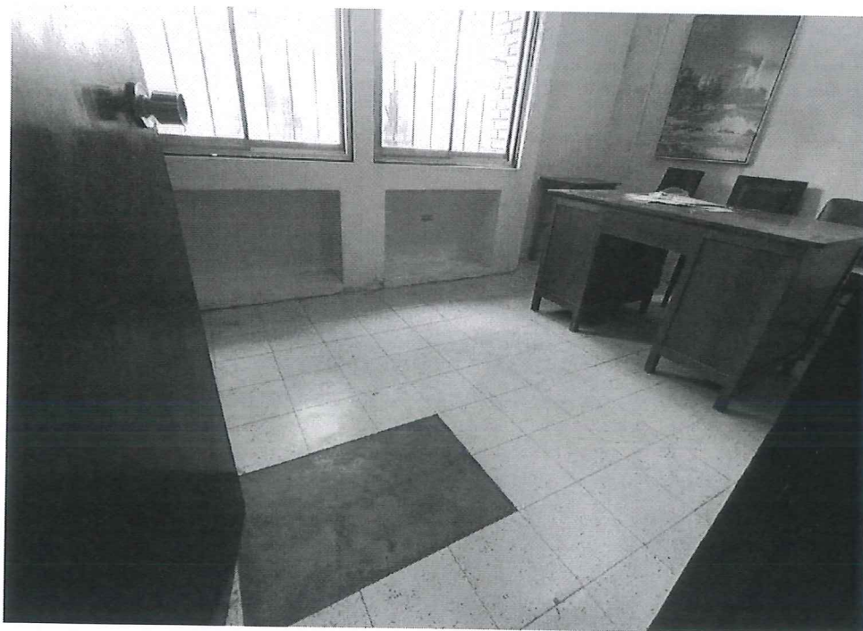
Pisos, en mal estado, tabiquería antigua apolillada, ambientes oscuros, ventanas rajadas, mobiliarios en mal estado
