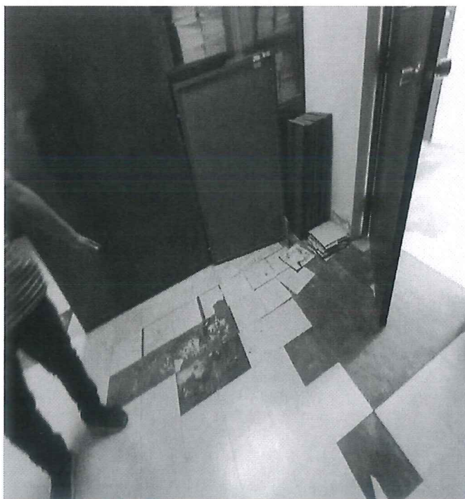
Pisos despegados por la antigüedad, retazos de carpintería de madera
