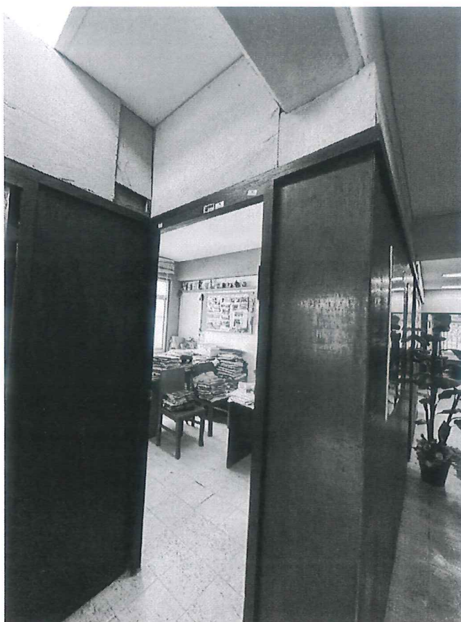
Tabiquerías improvisadas retazos de madera, pisos despegados, puertas y carpintería dañada
