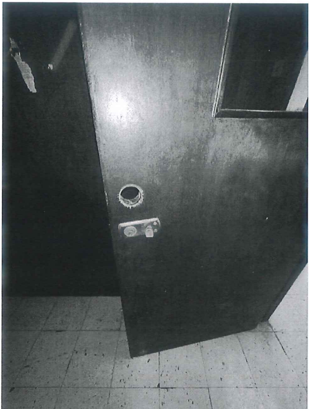
Puertas dañadas, sin chapa, picadas por polillas
