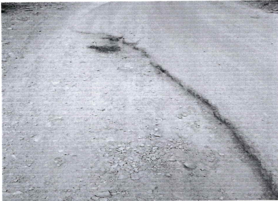
KM. 14+200 PAVIMENTO ASFÁLTICO REQUIERE SU PARCHADO EN LA CALZADA.
