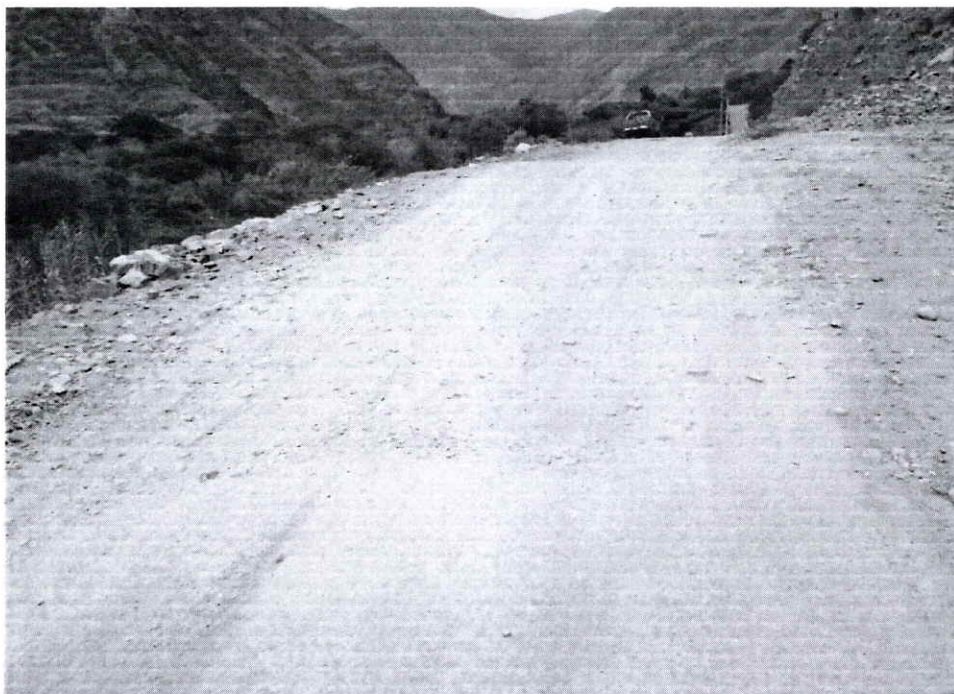
KM. 21+200 SE APRECIA EN LA CALZADA QUE REQUIERE SU PARCHADO DE LA VÍA.
