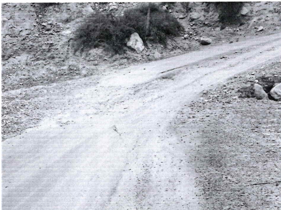
KM. 20+500 SE APRECIA PAVIMENTO DETERIORADO NECESITA SU PARCHADO ASFÁLTICO.
