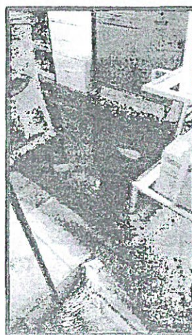
Fotografía 4: Inundación en los ambientes de Cadena de frío por las filtraciones de agua de lluvia en el Techo del Establecimiento de Salud.
