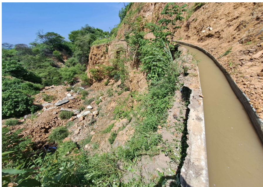
Fotografía N° 01: Canal rectangular – Talud erosionado lado lateral
