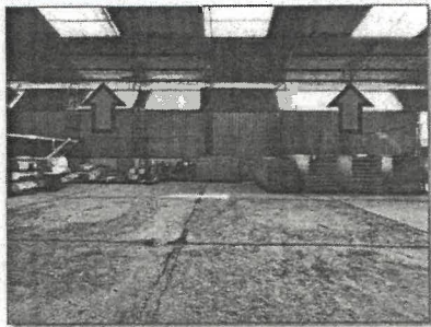
SE OBSERVA VACIOS DE 50CM EN LA PARTE FRONTAL DEL ALMACEN
