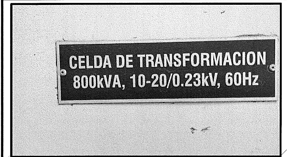
Imagen 02: Muestra los parámetros de la celda de transformación
