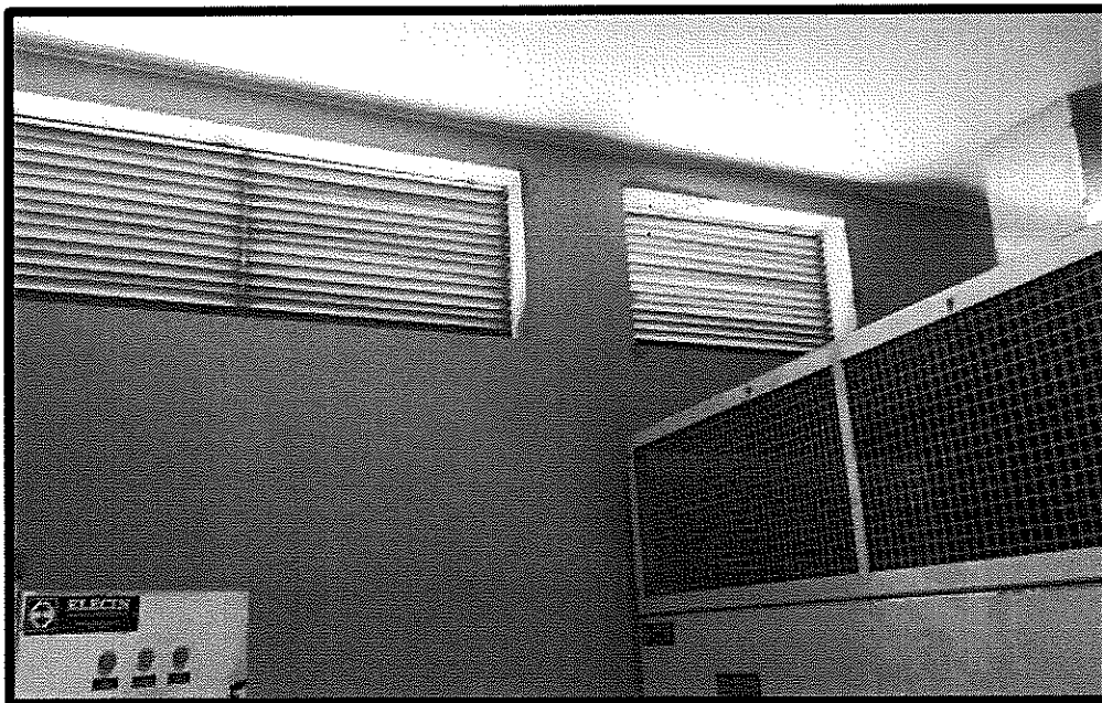
Imagen 10: Muestra las rejillas de ventilación, ubicadas al interior de la subestación
