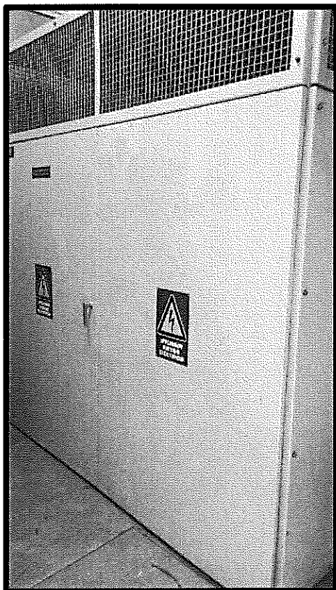
Imagen 05: Muestra las rejillas de seguridad de la celda de transformación
