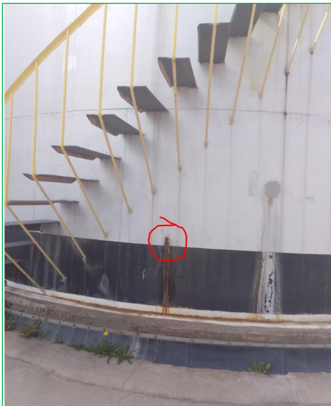
Imagen N° 02: Pitting identificado en el primer anillo del Tanque N° 05
