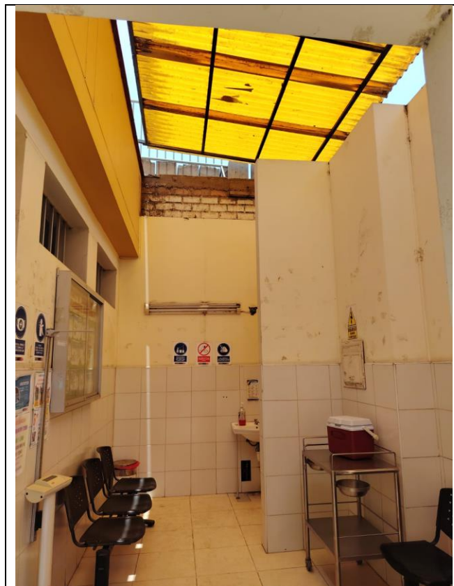
Foto 12. Se visualiza las paredes sucias en PCT, cobertura en mal estado, necesita cambio.
