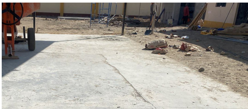
Fotografía N°2: Se muestra la losa existente con fisuras y deterioro.
