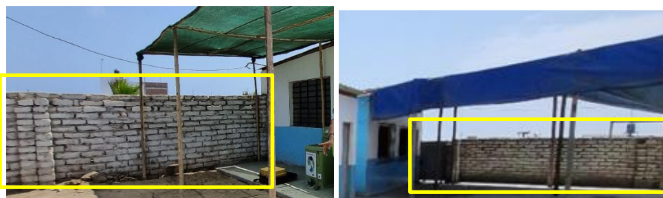
Foto N° 06: Vista del Cerco Perimétrico – Muro de adobe
