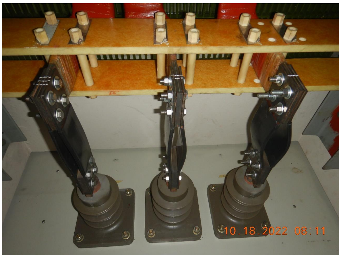
Foto 01 : Vista de terminales de fase y barra flexible de desconexión para pruebas eléctricas en el generador de potencia 63.5MVA
