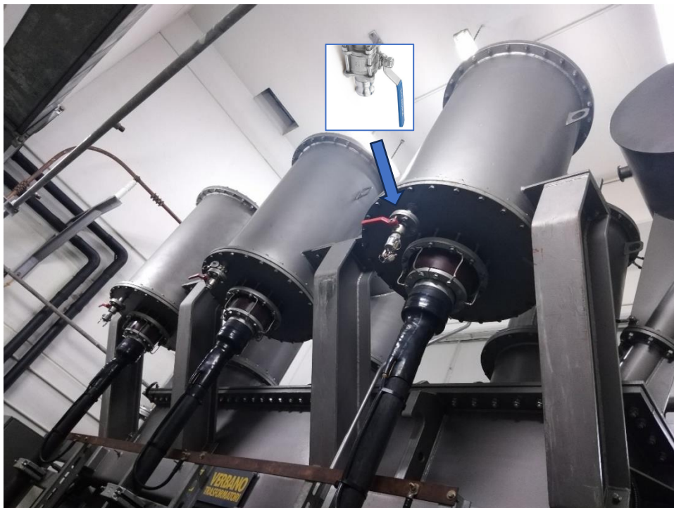
Foto 02 : Vista de muflas (fases U, V y W) lado cables de AT con válvulas de entrada/salida de aceite Ø1" con conector (macho) de acople rápido de Aluminio Tipo C – Camlock
