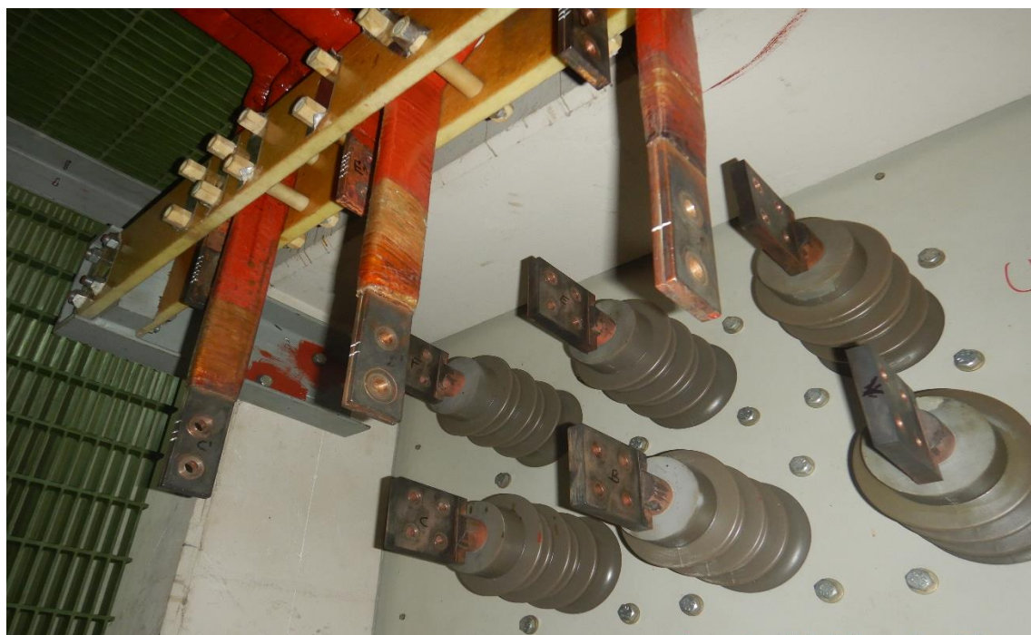
Foto 02 : Vista de terminales del Neutro y barra flexible de desconexión para pruebas eléctricas en el generador de potencia 63.5MVA
