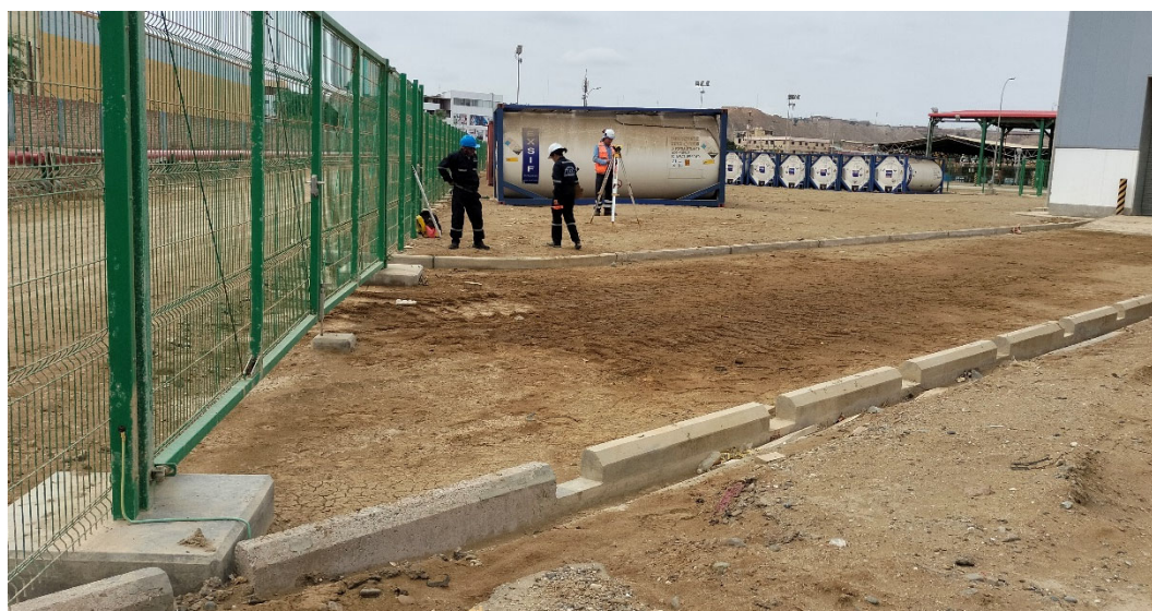
Imagen 3 Toma de puntos en terreno aledaño a oleoductos existentes
