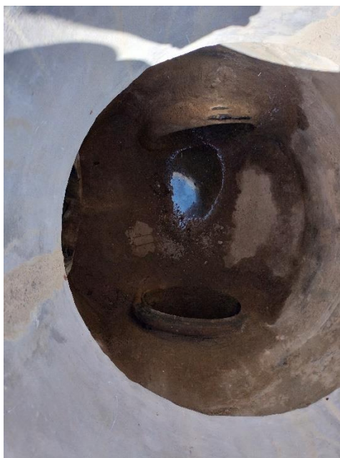
Imagen 8 Estado de ductos en B16
