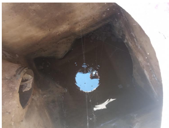
Imagen 7 Verificación de estado de ductos en R1 (4 puntos)
