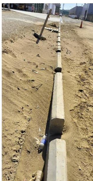
Imagen 11 Cuneta colmatada de arena y sedimentos
