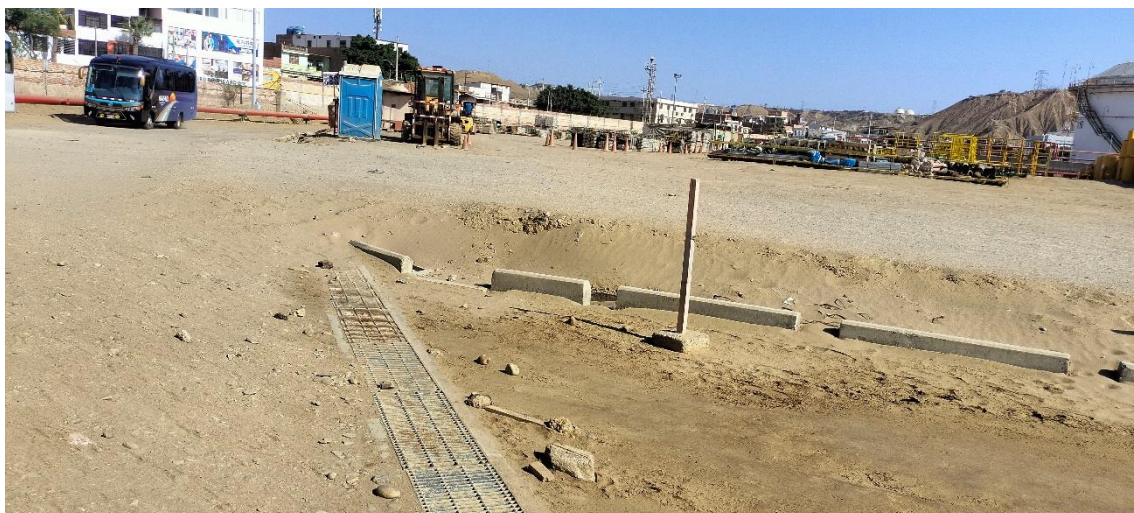
Imagen 10 Estado de rejilla que necesita ser limpiada y reparada
