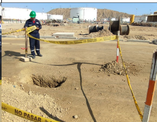
Imagen 9 Calicata Ps-4 zona de Sur de viales de edificios
