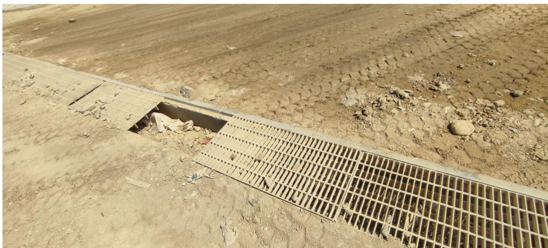
Imagen 13 Cuneta con rejilla que necesita limpieza y mantenimiento.
