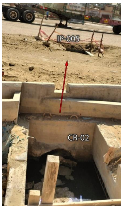
Imagen 5 Punto de entrega a RWS (IP-005), desde CR-02 - Verificar posición, pues la zona tiene varios buzones abiertos y zonas con material encima de tapas de buzón al momento del estudio.
