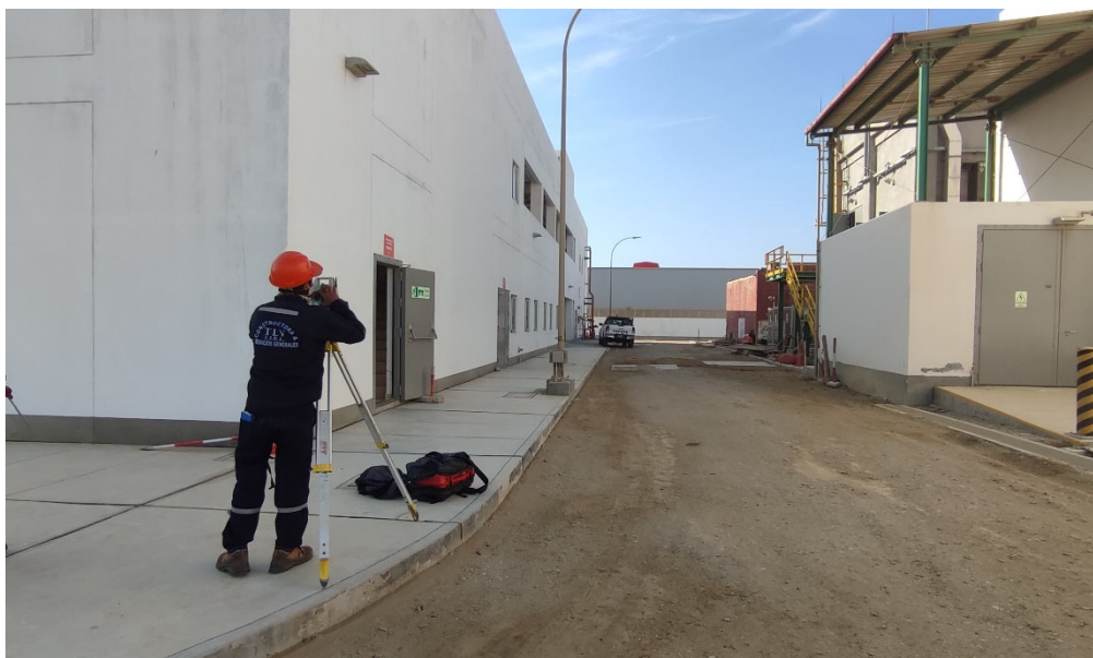
Imagen 1 Posición de Estación Total para toma de puntos del terreno.
