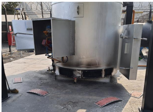
CAMBIO DE EMPAQUETADURAS DE LAS TAPAS DEL PLENUM
