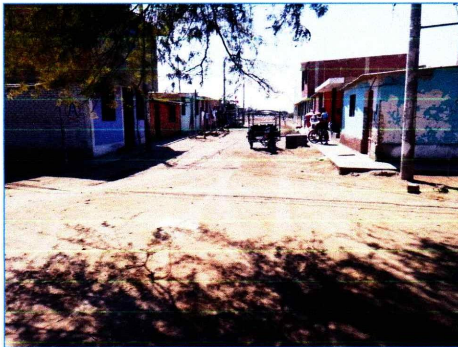
FOTO N° 05.- Presencia de baches y ahuellamientos en la calle Ricardo Peña.
