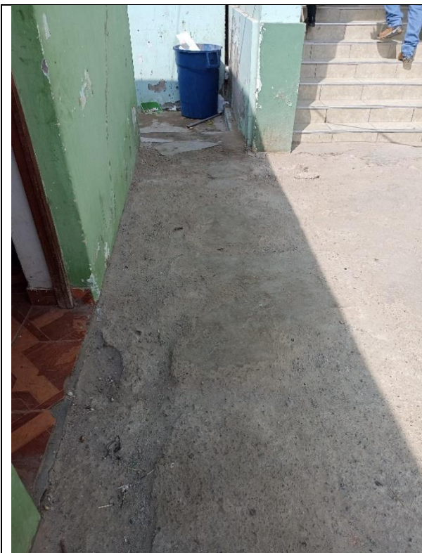
CONCRETO DE PISO PULIDO MEZCLA 1:8 CEMENTO-HORMIGON h=10cm
