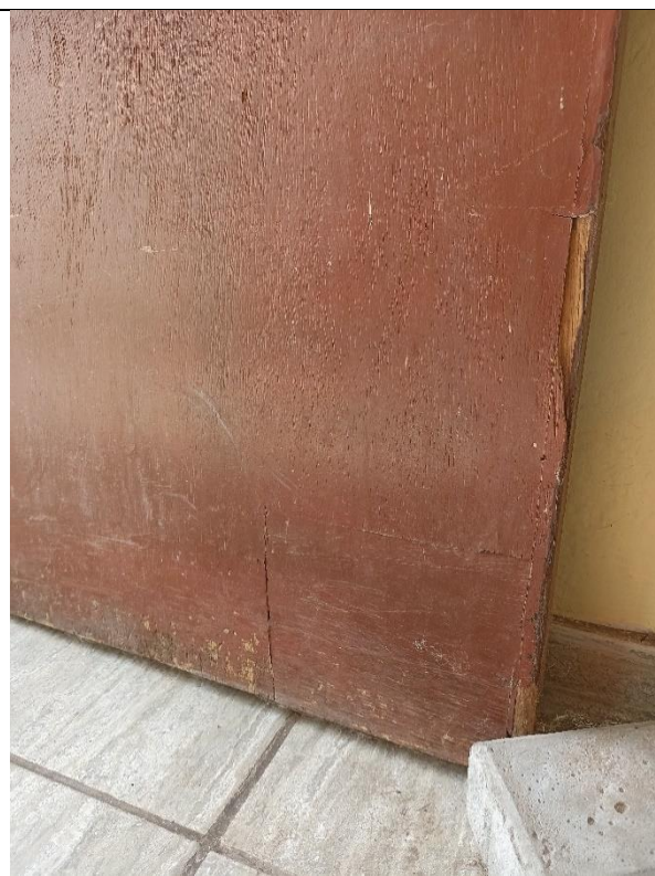
PUERTA CONTRAPLACADA DOS HOJAS C/MARCO DE MADERA 1.75 x 2.67m INC/VIDRIO - CERRADURA DOS GOLPES
