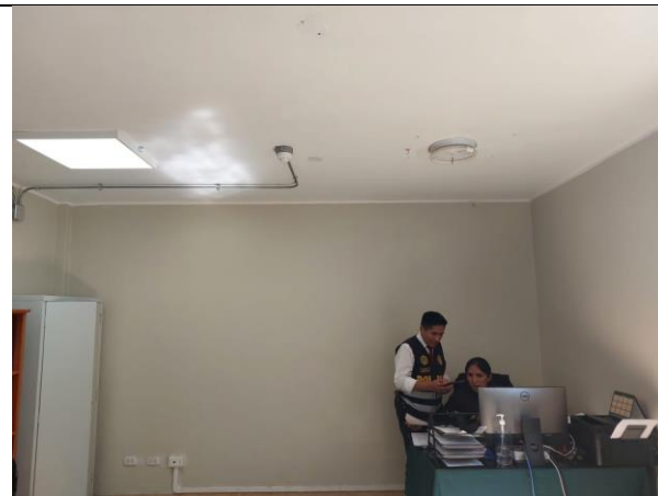
COLOCACIÓN DE LUMINARIA LED 60x60x48W
