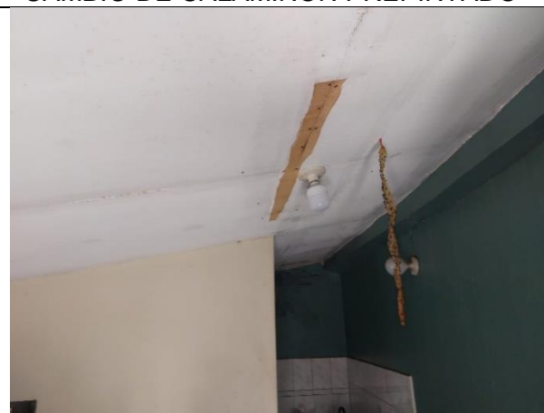
RETIRO DE TRIPLAY Y COLOCACION DE CIELO RASO CON PLANCHAS DE YESO
