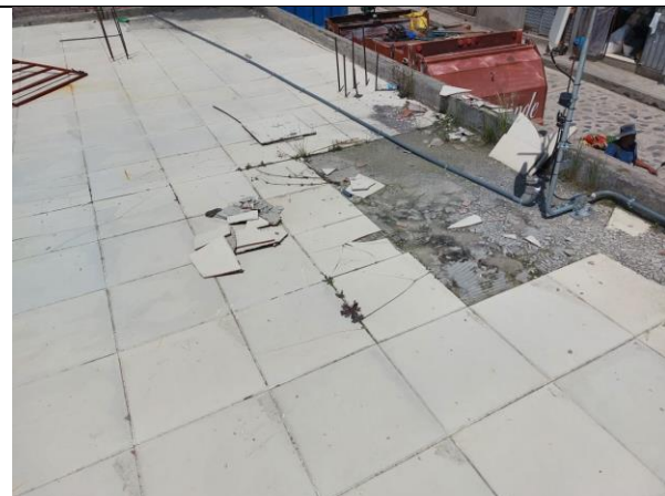
RETIRO DE CERAMICO Y DEMOLICION DE SOBRECARGA
