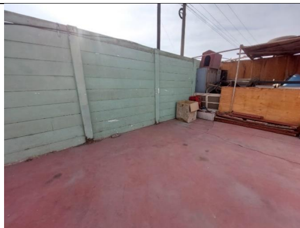
MUROS DE DRYWALL DOS CARAS (FRIBROCEMENTO-YESO) E=12cm
