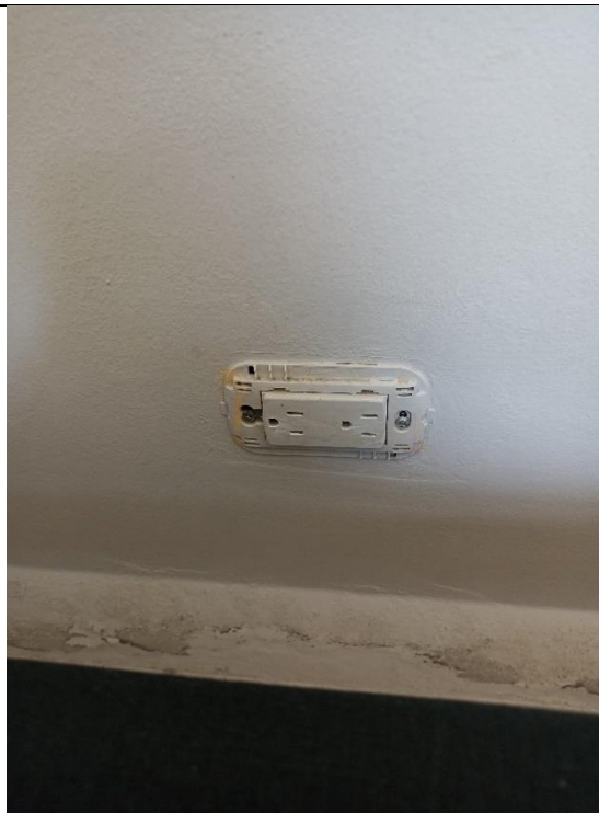
CAMBIO E INSTALACION DE TOMACORRIENTE DOBLE
