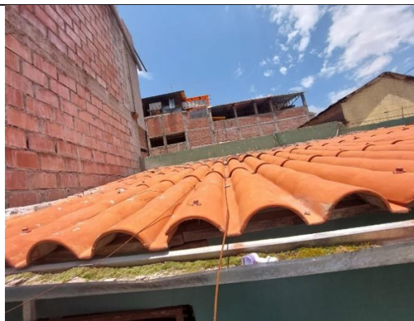
CANALETA ALUZINC 4" x 4" INC/SOPORTERIA METALICA
