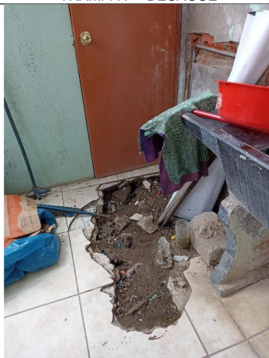
CONCRETO EN FALSO PISO MEZCLA 1:8 CEMENTO-HORMIGON E=15cm
