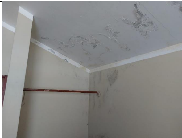
PINTURA LATEX 2 MANOS SATINADO EN CIELO RASO INC/SELLADOR ANTISALITRE
