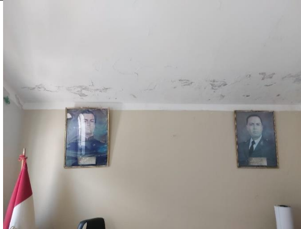
PINTURA LATEX 2 MANOS SATINADO EN CIELO RASO INC/SELLADOR ANTISALITRE
