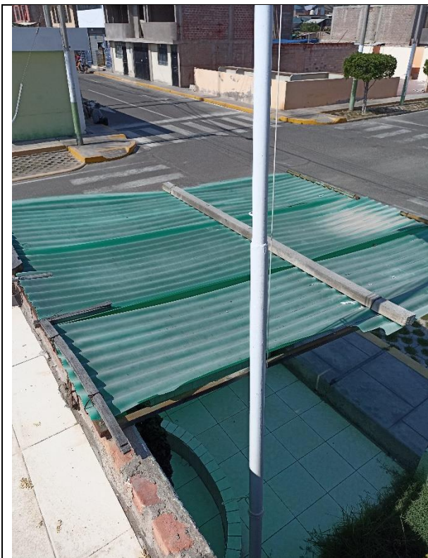
RETIRO DE COBERTURA DE CALAMINA PVC
