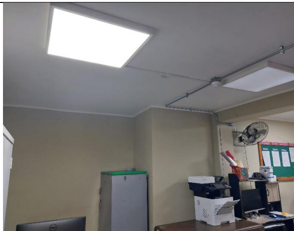
COLOCACIÓN DE LUMINARIA LED 60x60x48W
