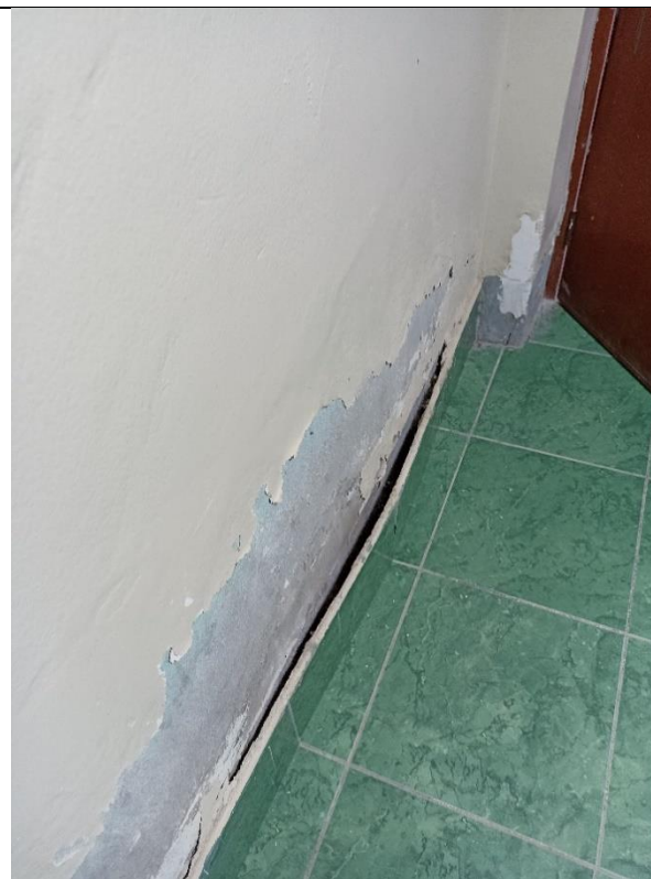
REPOSICION DE ZOCALO DE CERÁMICO h=0.20m EXISTENTE
