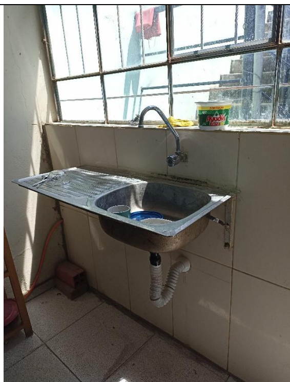
CAMBIO DE GRIFERIA TIPO GANSO - TRAMPA P - DESAGUE
