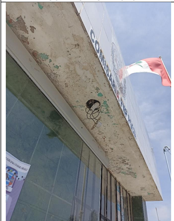
CAMBIO DE LUMINARIA HERMETICA LED P/EXTERIOR 1.20mx36W
