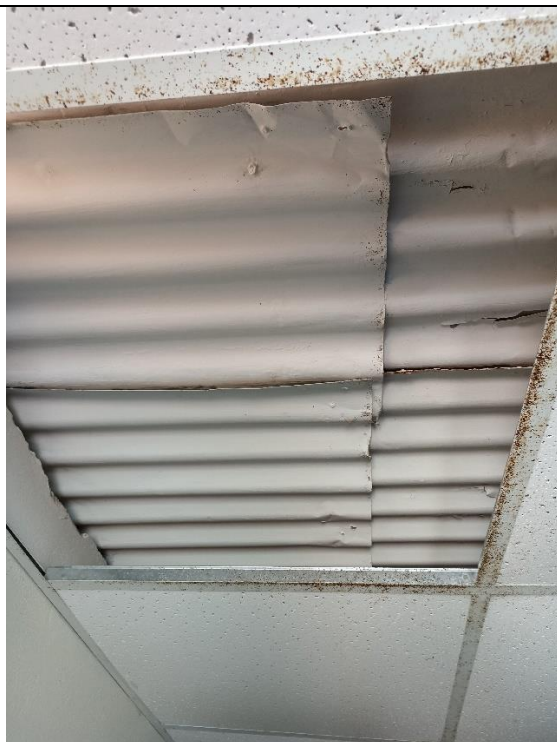
RETIRO DE COBERTURA DE CALAMINA FIBROCEMENTO
