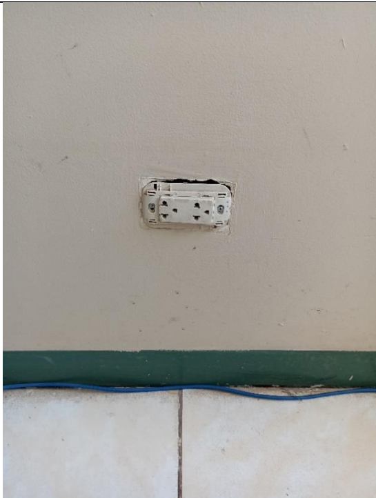
INSTALACION DE TOMACORRIENTE DOBLE
