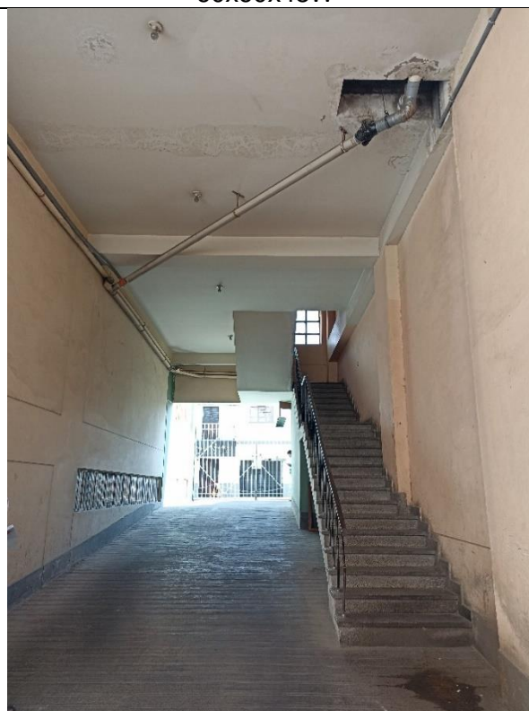
MEJORAMIENTO DE ACCESORIOS Y TUBERIA DE MONTANTE INC/ABRAZADERAS COLGANTES
