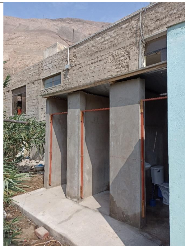
VACIADO DE SARDINEL a=0.10 , h=0.15m
