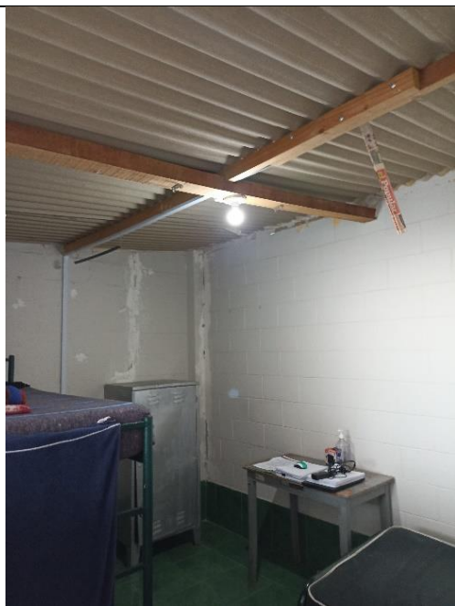
REFORZAMIENTO DE VIGA DE MADERA
