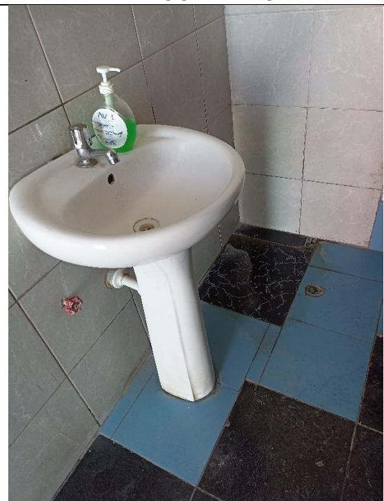
CAMBIO DE GRIFERIA LAVATORIO - TUBO DE ABASTO - TRAMPA DESAGUE
