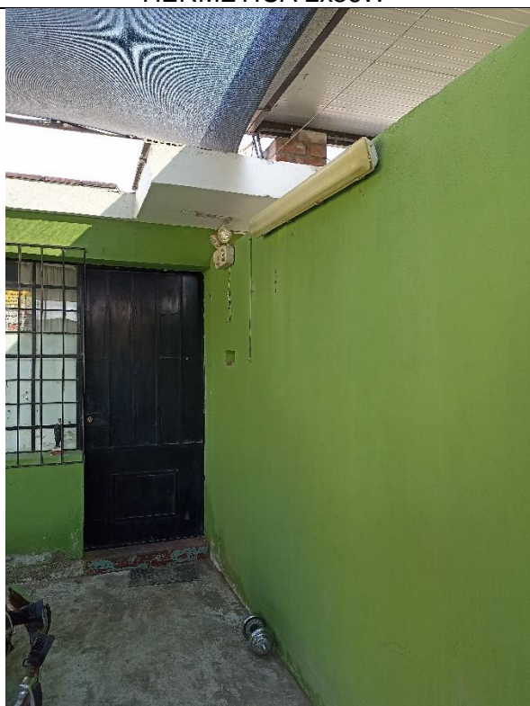
CAMBIO DE LUMINARIA LED HERMETICA 2x36W
