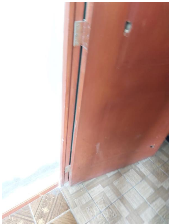
CAMBIO DE HOJA CONTRAPLACADA DE MADERA INC/BISAGRA 0.85x2.15
