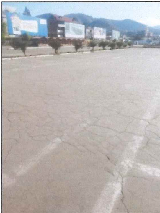
Fotografía N° 04: Piel de cocodrilo en el estacionamiento vehicular
