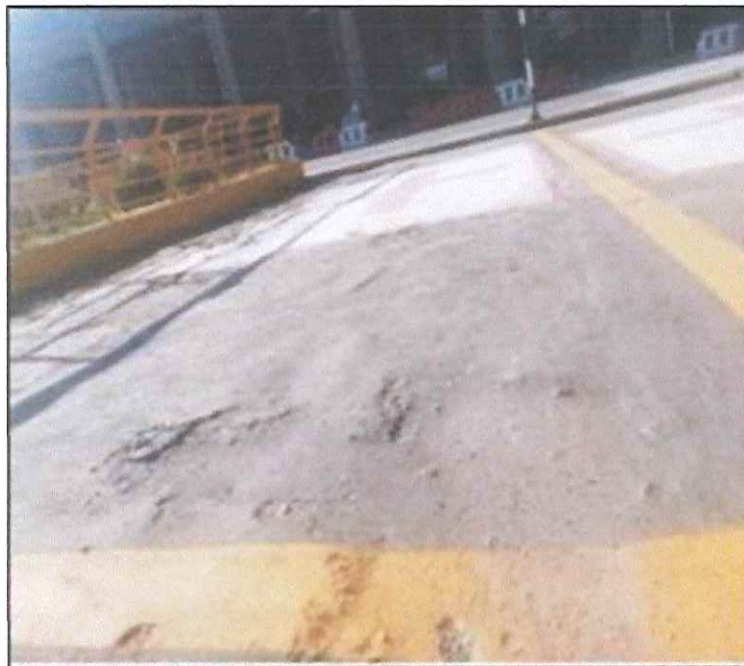
Fotografía N° 03: Huecos En El Estacionamiento Vehicular
