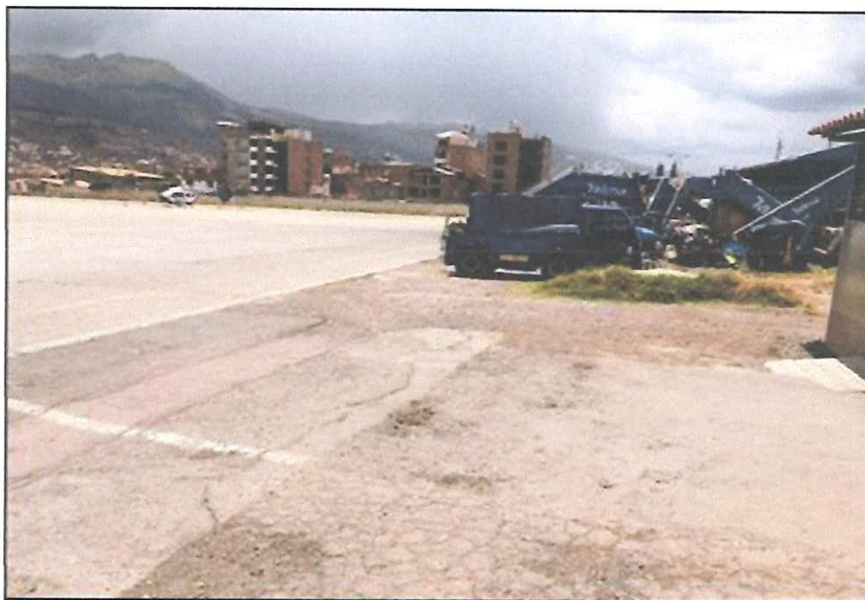
Fotografía N° 01: Pavimento deteriorado estacionamiento de equipos de rampa.
