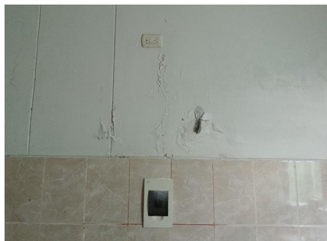
Vista del proceso de exfoliación de la pintura, ocasionado por la humedad. Se plantea repintado-ambiente sala de parto.
