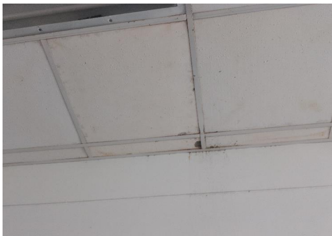
Vistas del cielo raso con baldosa con manchas, causado por la humedad. Se plantea cambio. Ambiente de cadena de frio
