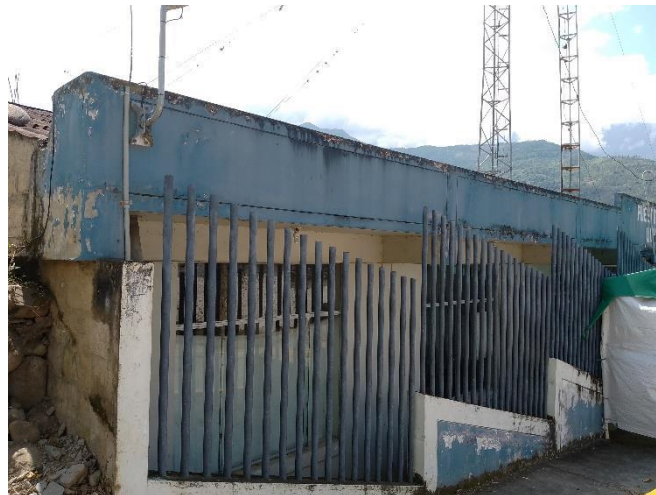
Vista donde se aprecia presencia de manchas con moho en la canaleta de concreto. Se plantea repintado.
