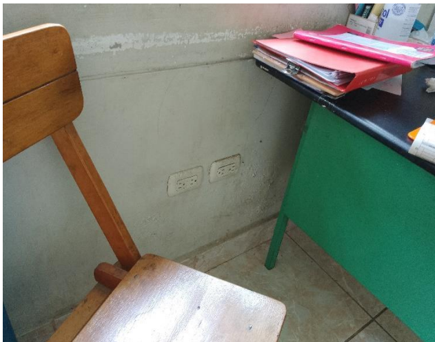
Pared sucia, causado por el tiempo de uso. Se plantea repintado-ambiente admisión.
