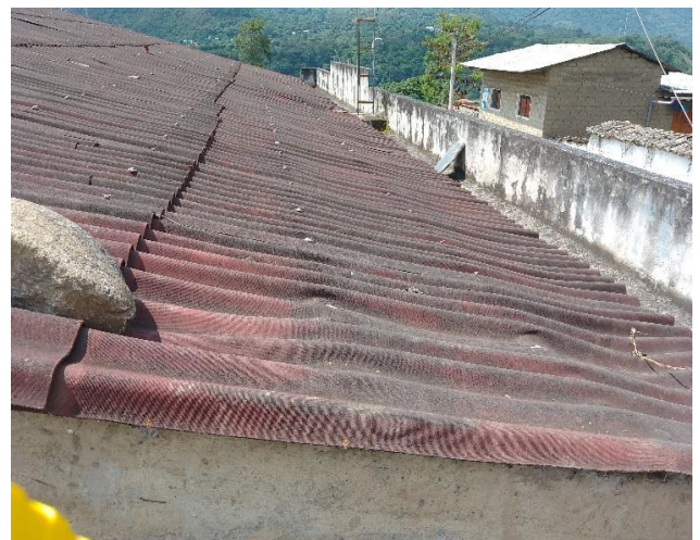
Vista a detalle del material de cubierta con daños generalizados. Se plantea cambio total
