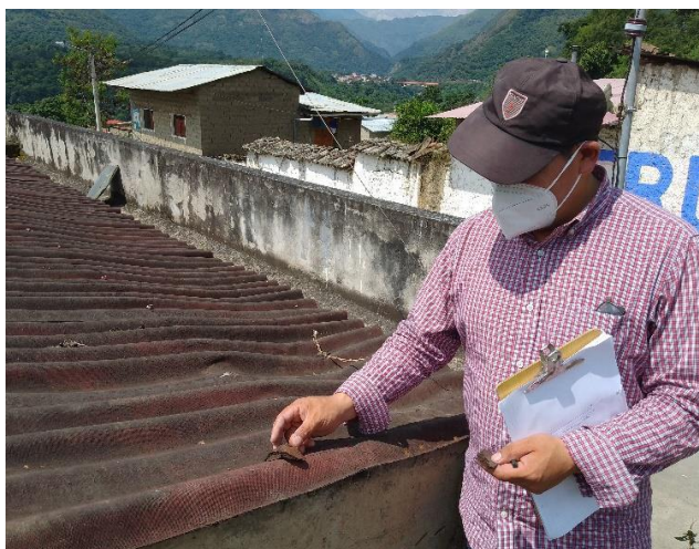
Vista del especialista que demuestra la descomposición del material de cubierta. Se plantea cambio total
