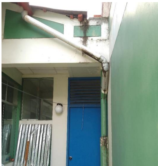
Tubería de desfogue de aguas pluviales dañados. Se plantea cambio. Canaleta interna
