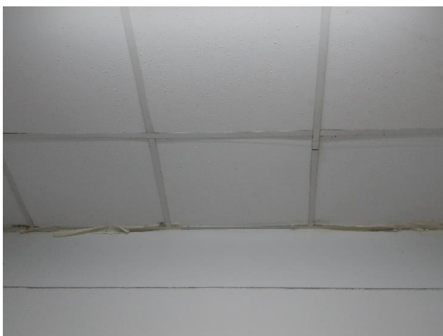
Se aprecia desprendimiento de las juntas entre baldosas del techo. Se plantea cambio de los sujetadores de baldosa-ambiente farmacia
