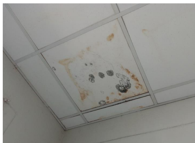
Vista del cielo raso con baldosa, presencia de manchas con moho, causado por la humedad. Se plantea cambio-ambiente CRED
