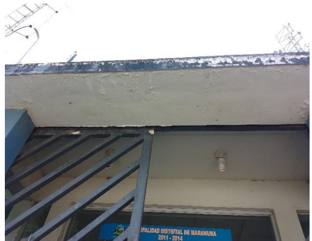
Vistas del proceso de exfoliación de la pintura. puerta principal. Se plantea resane y repintado
