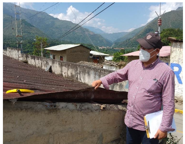
Vista del especialista que demuestra el daño generalizado e irreversible de la cubierta. Se plantea cambio total
