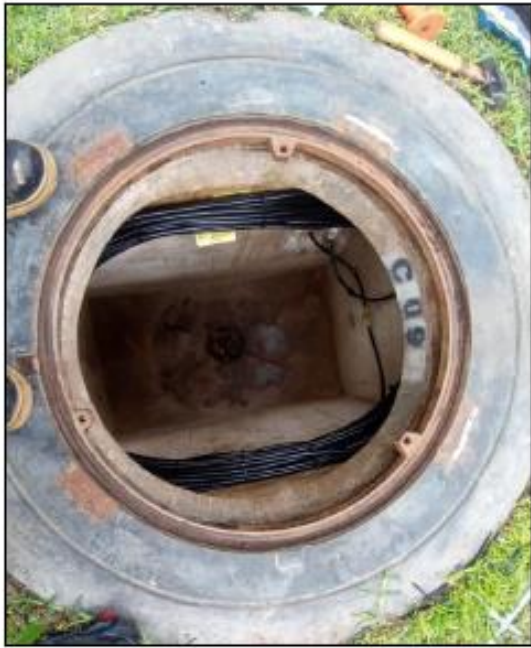
Tipo de identificación de cámara de comunicaciones
