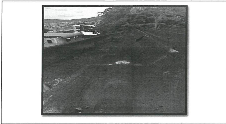
Superficie de techo y canaleta de aguas pluviales con materia orgánica.
