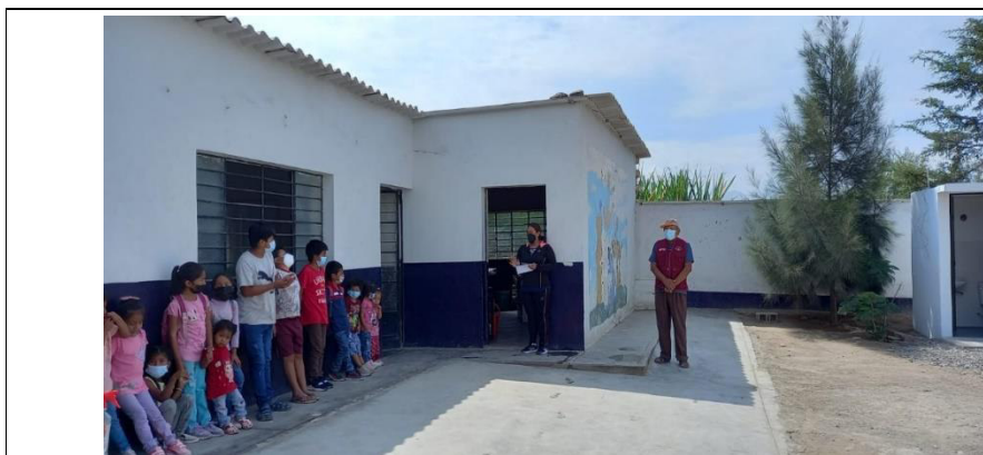
Fotografía N° 01: Vista del Aulas con la que cuenta la I.E, las cuales actualmente son de material de Adobe
