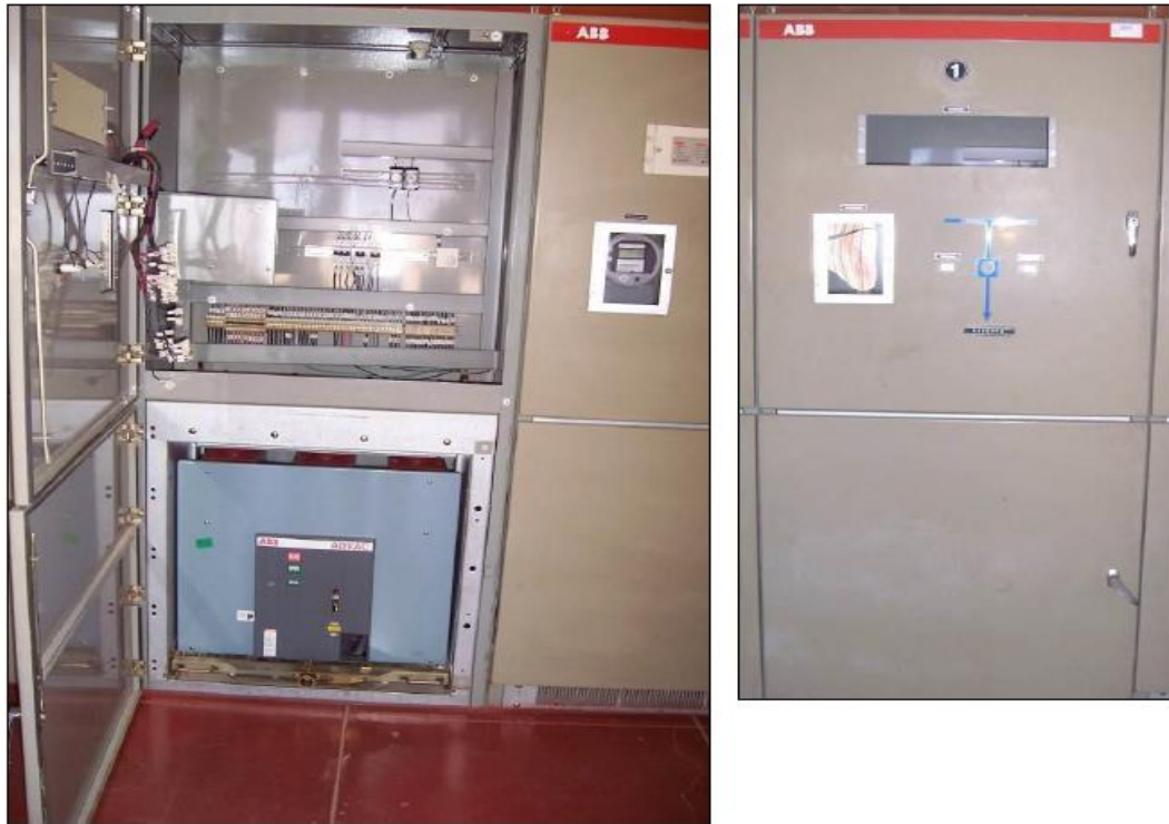
Figura 1. Celdas de 10 kV marca ABB deteriorada
