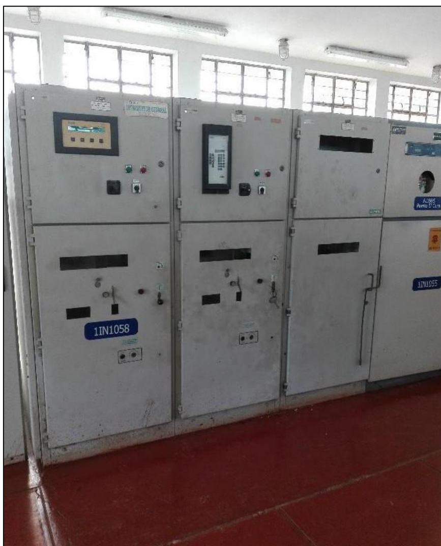
Figura N° 1. Celdas de 10kV marca SIEMENS deterioradas.
