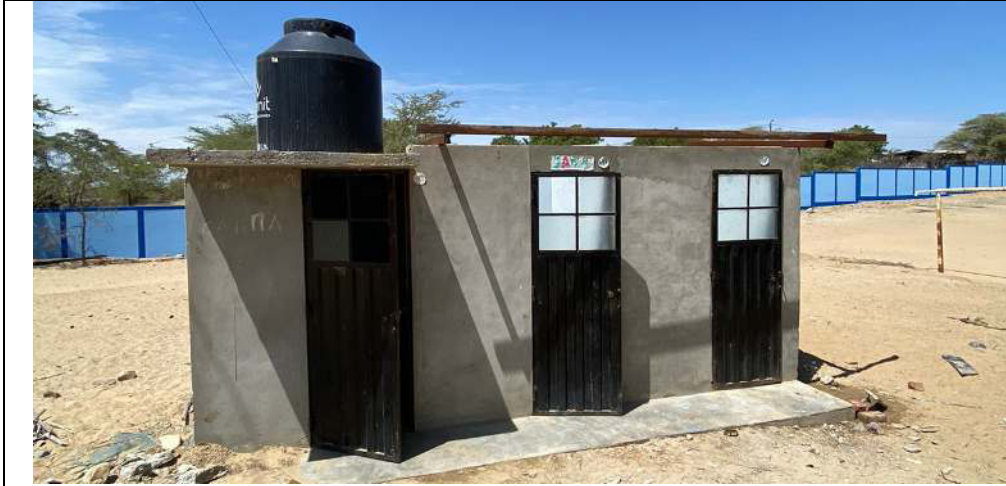
Fotografía N°07: Se visualiza estructura de albañilería sin techo o cobertura.
