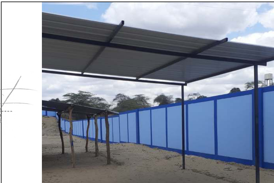
Fotografía N°06: Se visualiza áreas techadas con soportes metálicos y madera rolliza
