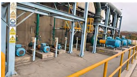
SISTEMA DE CLORACIÓN Y CONTRALAVADO DE FILTROS
