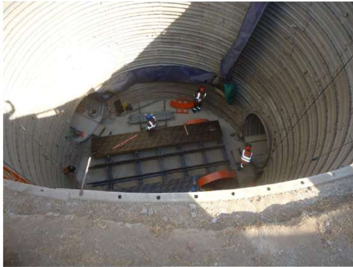
Vista fotográfica N° 3: Vista de túnel liner de la cámara de derivación en proceso de construcción
