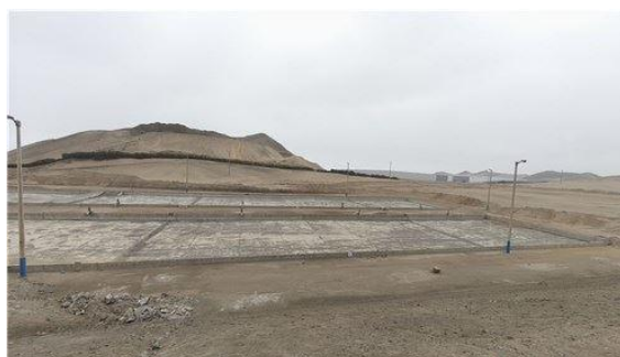
Zona Sur - Lecho de secado de lodos
