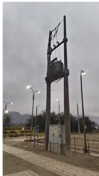
BOCATOMA-TRANSFORMADOR BIPOSTE
