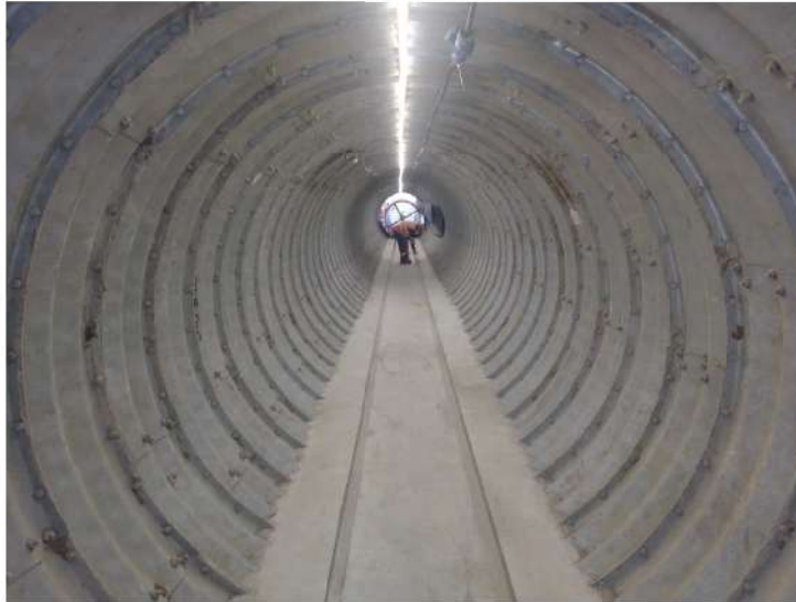
Vista fotográfica N° 7: Vista interior del túnel liner horizontal instalado al 100%
