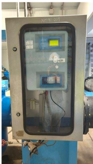
R. JICAMARCA - SENSOR DE CLORO
