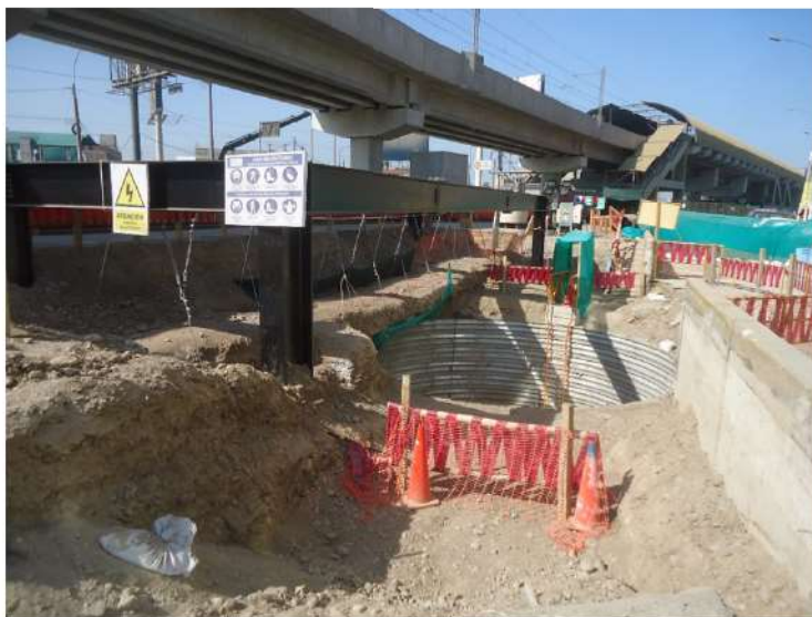
Vista fotográfica N° 5: Vista de la cámara de empalme CDE-01 en construcción
