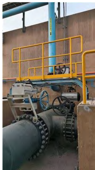
SISTEMA DE LAVADO DE FILTROS
