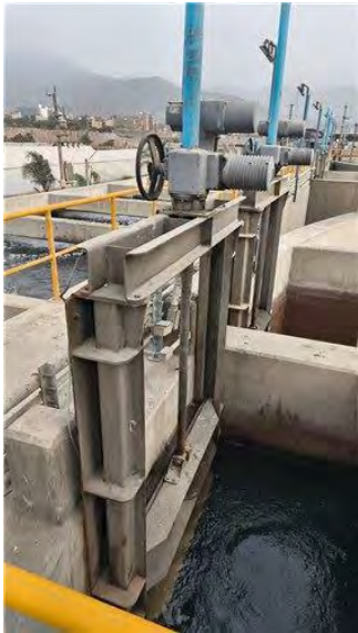
COMPUERTA TANQUES DE CONTACTO
