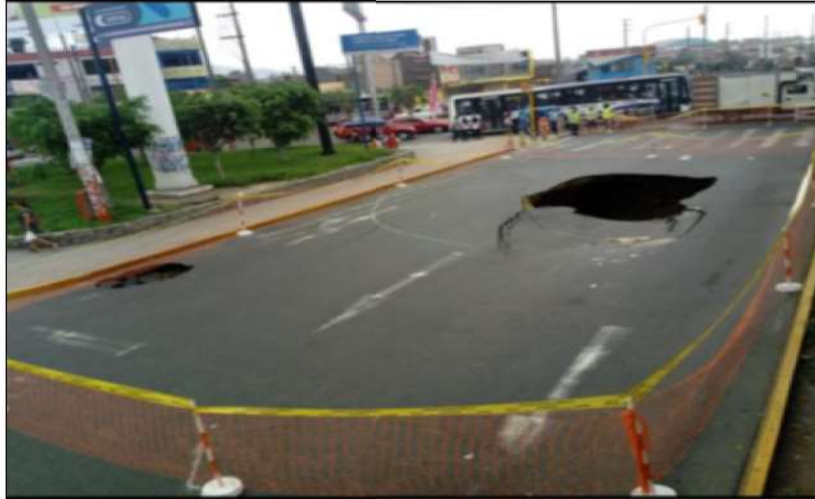
Vista fotográfica N° 1: Vista de los forados iniciales sobre el Pavimento de la Av. Próceres de la Independencia.
