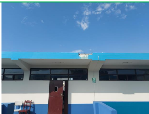
Edificación 1, mal estado de las viguetas
