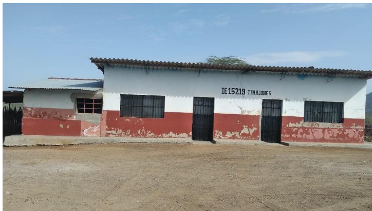
Fotografía N°2: pabellón de aula sin uso y cocina, de material adobe con presencia de grietas
