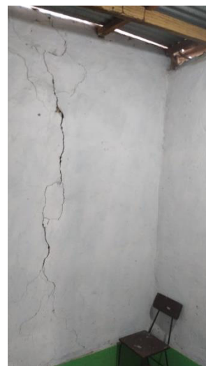
Fotografía N°2: pabellón de aula sin uso y cocina, de material adobe con presencia de grietas
