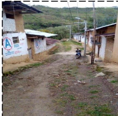
IMAGEN 15: Estado actual de la calle Cutervo cuadra 03, se verifica que no cuenta con pistas ni veredas, superficie de rodadura en terreno natural en mal estado. en la parte central de la cuadra se nota un buzón existente del sistema de alcantarillado.
