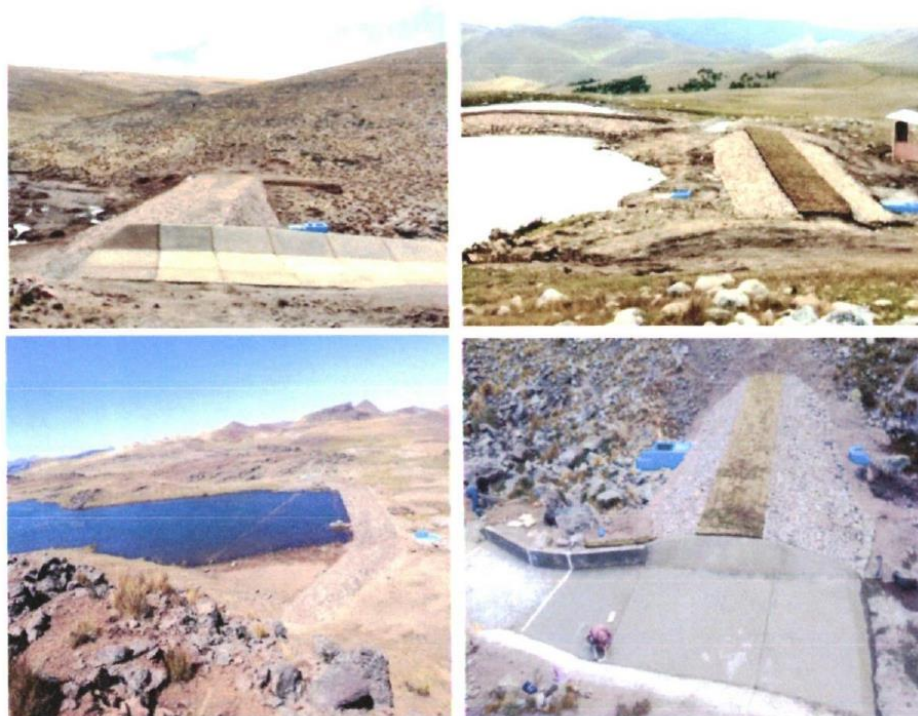
Figura N° 5: Vista de Colocación de Piedra en Talud Aguas Arriba y Abajo
