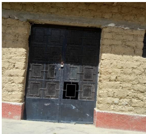
Fotografía N° 10: Vista exterior de la Almacén de alimentos de Qaliwarma de la I.E.86712 construido con material precario (adobe), presenta deterioro en los muros de adobe. Por lo cual se recomienda la demolición
