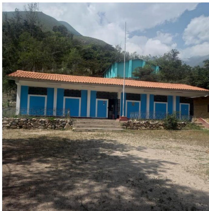
Fotografía N° 02: Vista del Módulo educativa de material del noble (02 Aulas) y losa de material concreto simple en regular estado de la I.E. 86712
