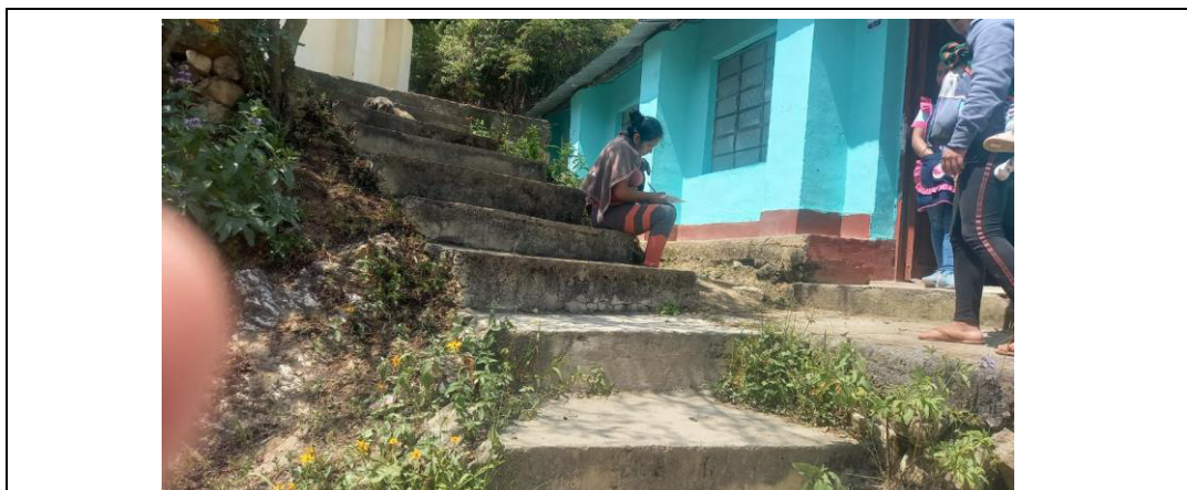
Fotografía N° 14: Vista de las gradas de concreto de la I.E.86712 construido sin dirección técnica, presenta deterioro. Por lo cual se recomienda la demolición.
