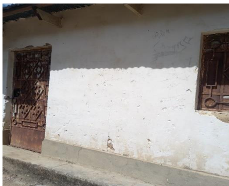
Fotografía N°08: Vista exterior del kiosco de la I.E.86712 construido con material precario (adobe), presenta deterioro en los muros de adobe. Por lo cual se recomienda la demolición
