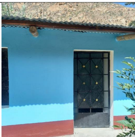
Fotografía N° 05: Vista exterior de la Cocina de la I.E.86712 construido con material precario (adobe), presenta deterioro en los muros de adobe. Por lo cual se recomienda la demolición
