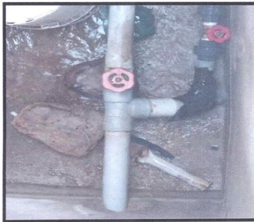
FOTOGRAFIA N° 2 CAMBIO DE ACCESORIOS SANITARIOS
