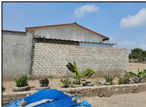
Imagen 2: Se muestra el muro de adobe en mal estado, con posible colapso al no contar con columnas.
