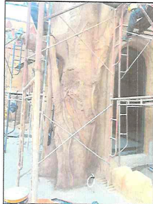
Imagen referencial: Proceso de instalación del recubrimiento de fibra de vidrio
