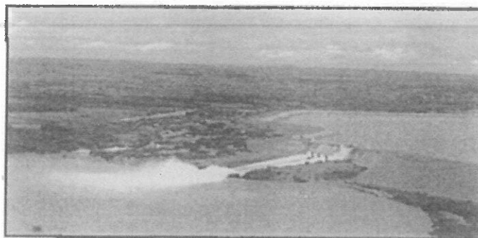
IMAGEN 01: Fotografía que muestra el aliviadero de la Presa de Poechos durante su operación. Obsérvese el efecto del Salto de Esquí.
