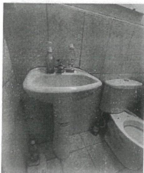
FOTO N°1 SS-HH: PRESENTA FILTRACIONES EN LOS APARATOS SANITARIOS
