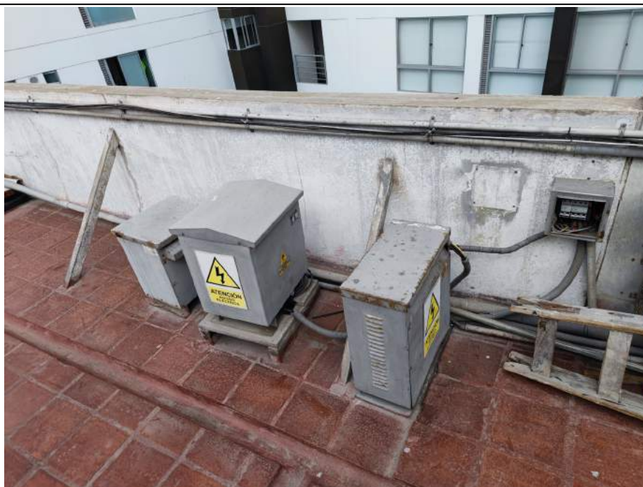
CONDICION ACTUAL DE TRANSFORMADORES DE AISLAMIENTO
