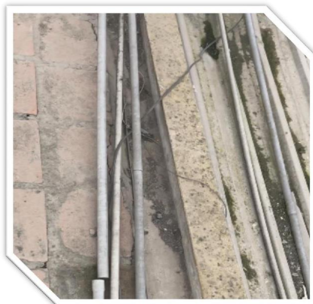
Fotografía N°2: Tendido de Fibra Tuberías PVC defectuosas (Techo del Instituto)
