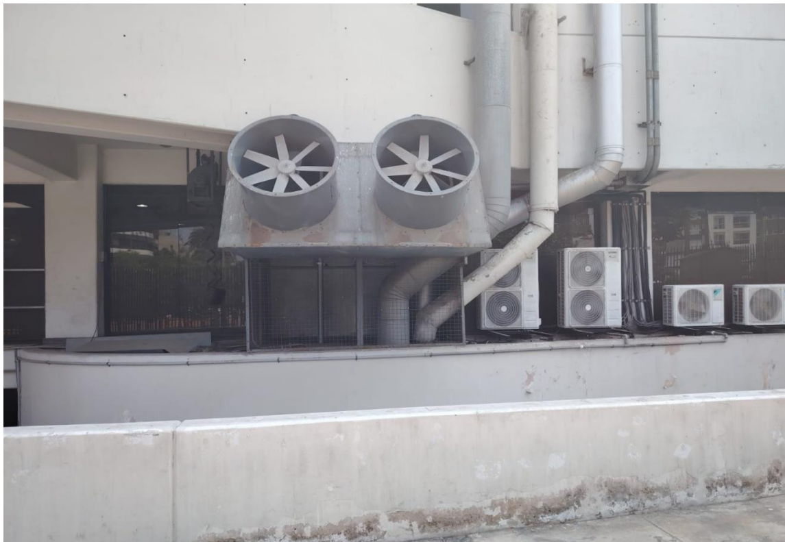
Fotografía 2. Vista de extractores en zona de ingreso a estacionamiento
