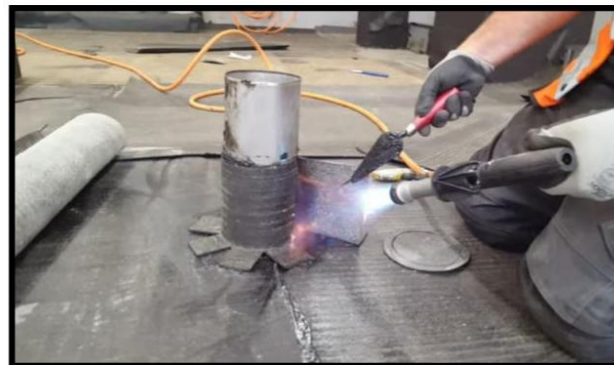
En esta imagen se muestra la segunda capa para sellar la tubería.
