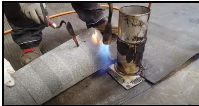
En esta imagen se muestra la primera capa del sellado de una tubería aplicando el Manto Asfáltico con sumo cuidado sin dañar la tubería.
