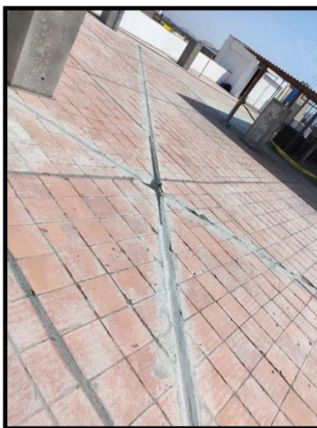
Foto de la Situación Actual de la Azotea del Módulo Penal – NCPP Nuevo Chimbote, donde se logra ver los SUMIDEROS Y CANALETAS EXISTENTES.
