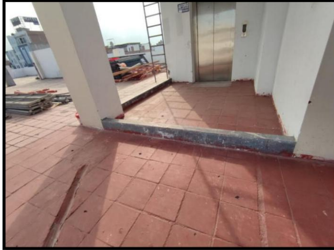
Zócalos a revestir por donde se ubica la salida del ascensor en toda la longitud de h=20\text{cm}
