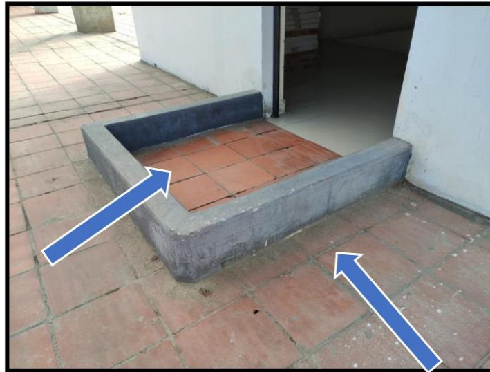
Zócalos a revestir por donde se ubica la salida de la escalera en toda la longitud de h=20\text{ cm}
