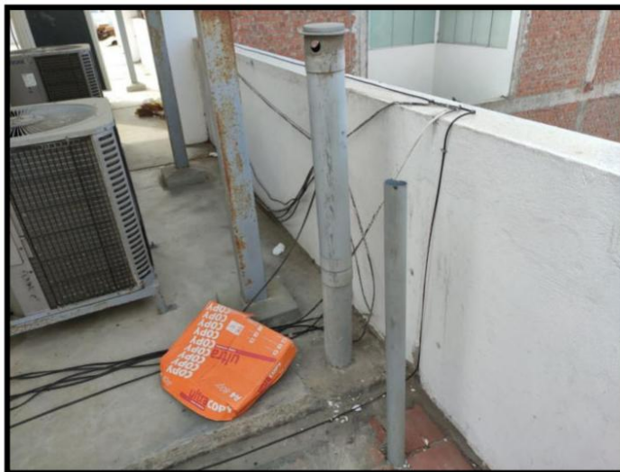
Tuberías a recubrir, son tuberías de PVC que funcionan como ductos de ventilación de los pisos inferiores.
