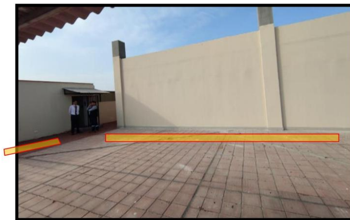
Imagen donde se aprecia los zócalos a instalar en la superficie de la tabiquería de Drywall.
