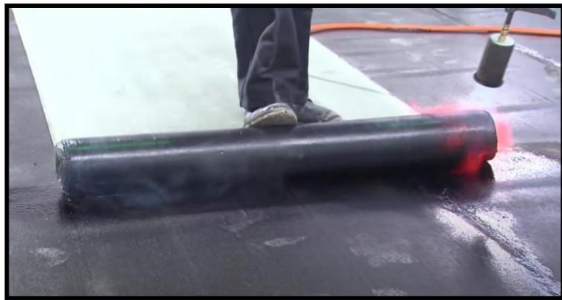
Imagen Referencial de la instalación del Manto Asfáltico aplicando Termo sellado utilizando soplete a gas. Las medidas de los traslapes por ningún motivo serán menores a las indicadas en la ficha técnica del producto
