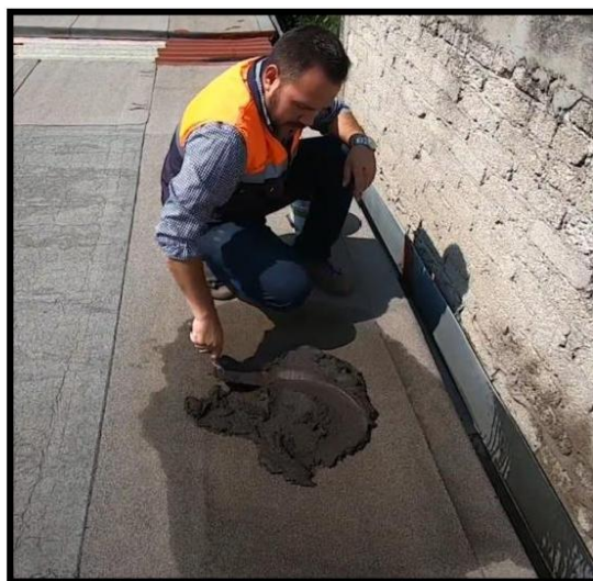
Imagen referencial de la aplicación del mortero asfaltico en el área a intervenir.
