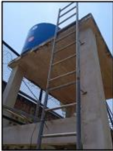
Imagen N° 7: Escalera de gato donde se colocará guarda hombres para proteger al personal de seguridad.
