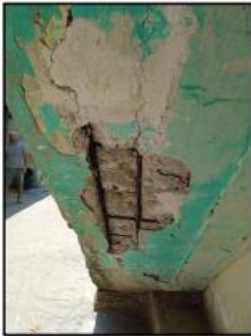
Imagen N° 2: Podemos apreciar la parte inferior de la escalera que está en pésimas condiciones.
