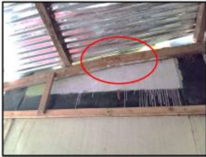
Imagen N° 13: Podemos apreciar vigas de madera rota, se plantea reemplazar por estructura metálica en el área de pabellón de mujeres.
