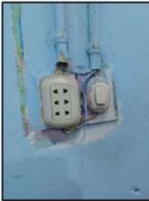
Imagen N° 10: Cables expuestos, se plantea empotrar y ocultarlos ya que es un peligro.
