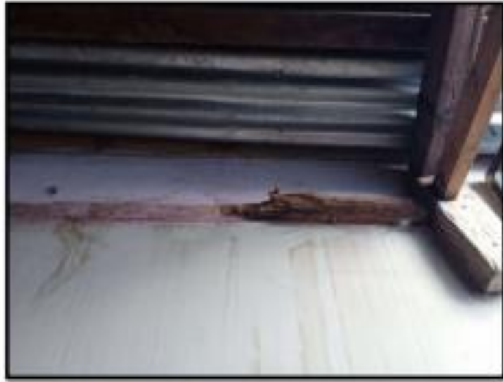
Imagen N° 11: Podemos apreciar vigas de madera en muy mal estado, se plantea reemplazar por estructura metálica.
