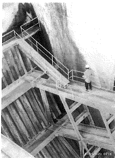
Vista posterior del tablero vigas y tablero con pintura dañada
