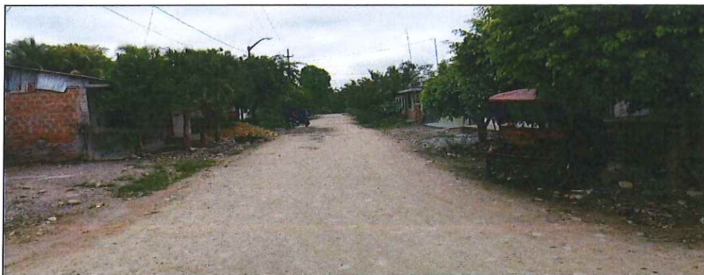
Jr. Bolognesi C-01, en el cual no existe sistema de drenaje pluvial, siendo necesario su ejecución, se proyecta cunetas y alcantarillas.
