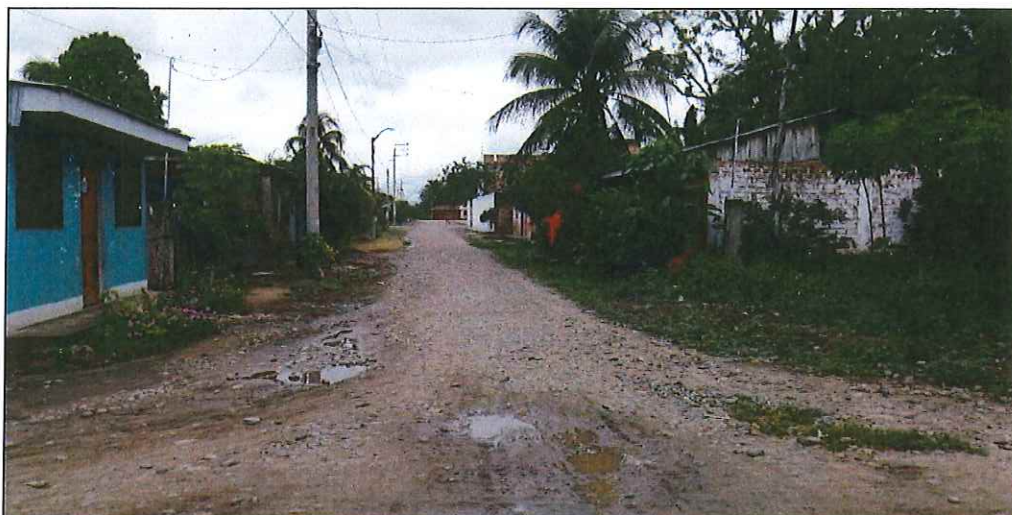
Jr. Sargento Lores C-02, en el cual no existe sistema de drenaje pluvial, siendo necesario su ejecución, se proyecta cunetas y alcantarillas
