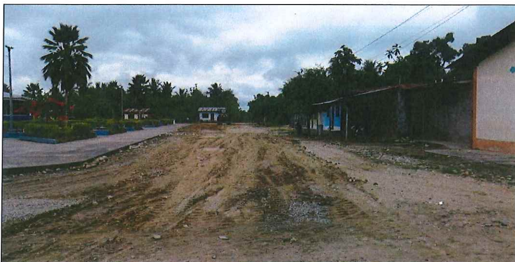
Jr. Alfonso Ugarte C-02, en el cual no existe sistema de drenaje pluvial, siendo necesario su ejecución, se proyecta cunetas y alcantarillas
