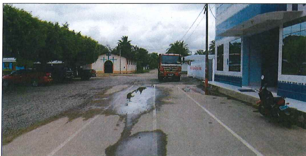
Jr. Sargento Lores C-02, en el cual no existe sistema de drenaje pluvial, siendo necesario su ejecución, se proyecta cunetas y alcantarillas
