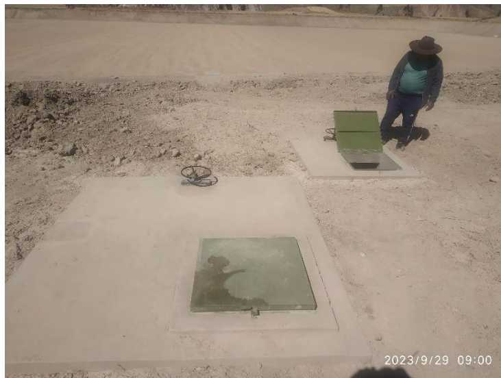
Sistema de carga del reservorio con 02 tuberías de Diámetro = 8"
