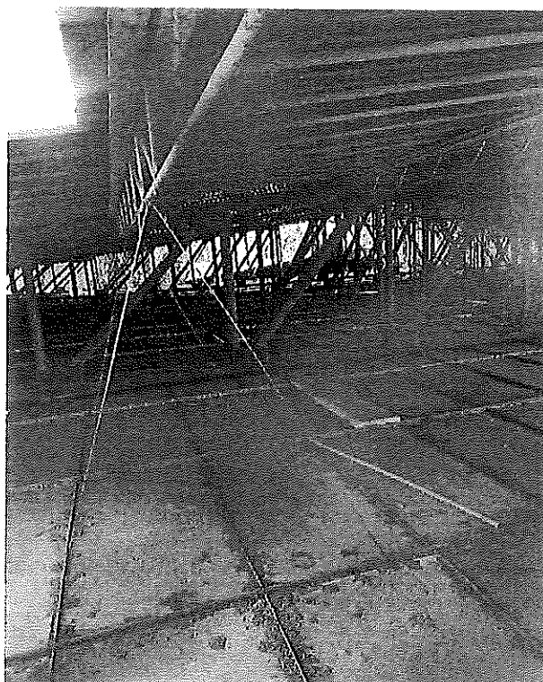
Estructura metálica de cubierta con presencia de óxido por falta de mantenimiento
