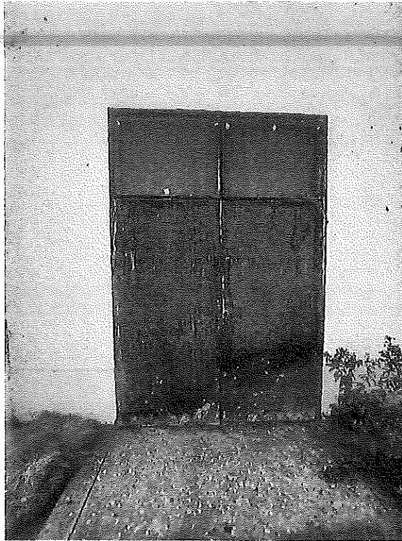
Presencia de desgaste y deterioro en puertas contra placadas externas.
