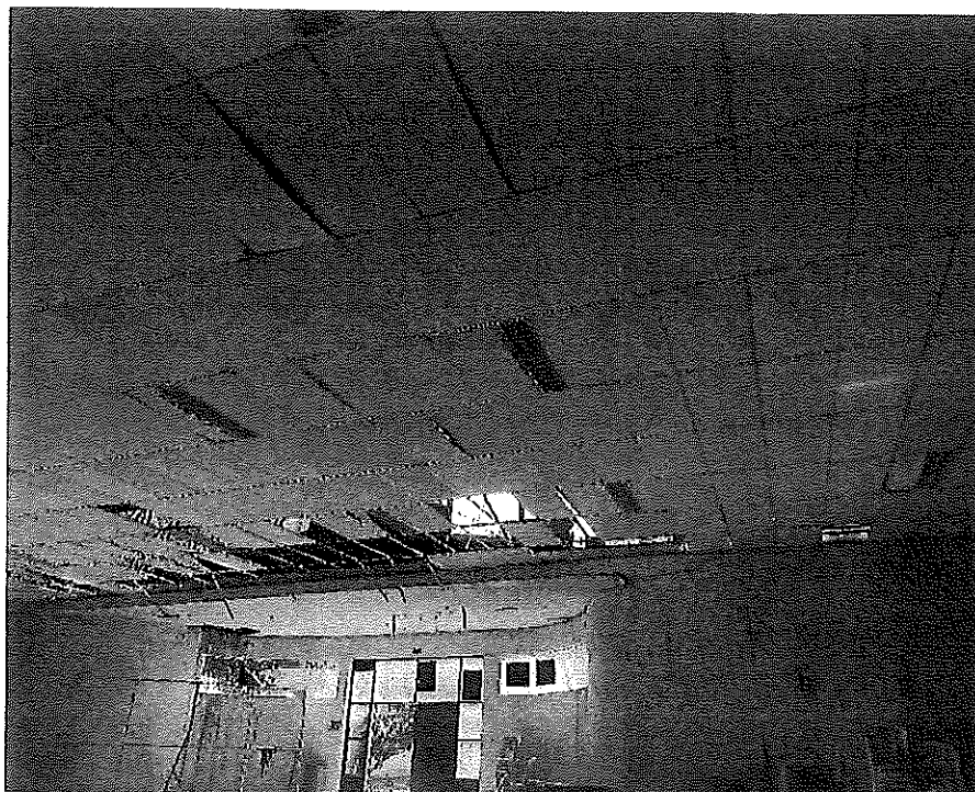
Falso cielorrasos dañados, luminarias oxidadas y sin uso, pisos deteriorados, puertas y vidrios.
